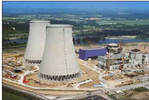
Figura2. Torri di raffreddamento di una centrale termoelettrica: servono a smaltire il calore ceduto dal ciclo termodinamico dissipandolo nell'ambiente.
