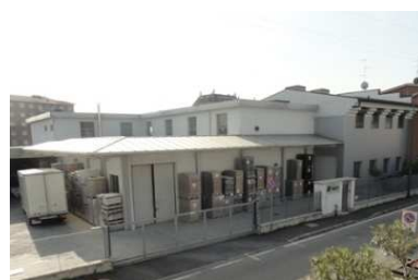
fig.II- 67 In questa immagine la presenza di imballaggi indica chiaramente l'esistenza d'una attività lavorativa.
