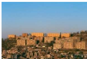
fig.III- 91 Il quartiere prima della demolizione
