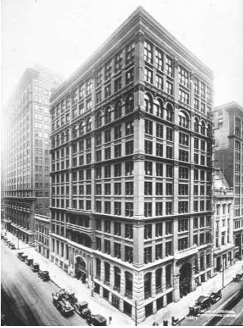
fig.III- 136 L'Home Insurance Building a Chicago costruito da William le Baron Jenney. È il primo grattacielo che fece la sua comparsa in città nel 1885. Verrà poi demolito nel 1931 per costruire una banca. Si trattava della prima struttura provvista di uno scheletro realizzato interamente in ferro e in acciaio; contava dieci piani ed era alto 138 piedi.
