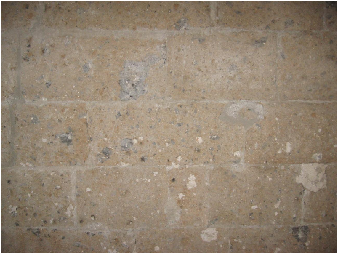
213. Nepi, chiesa di San Biagio, presbiterio, parete Sud, particolare della muratura.
