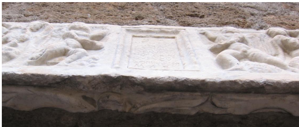
201. Nepi, chiesa di San Biagio, portale, architrave, particolare.
