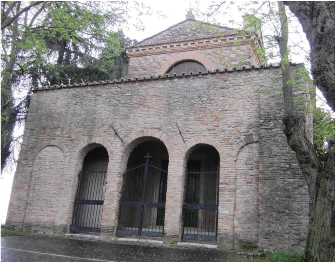
388. Nazzano, Sant'Antimo, facciata.
