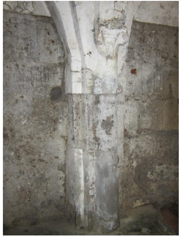
74. Castel Sant'Elia, basilica di Sant'Elia, cripta, parete Nord, particolare.
