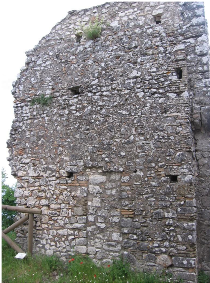
284. Sant'Oreste, monte Soratte, monastero di San Silvestro, torre, lato Ovest.
