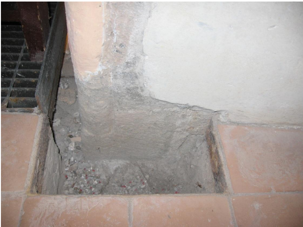
220. Nepi, chiesa di San Biagio, parete Sud, particolare.
