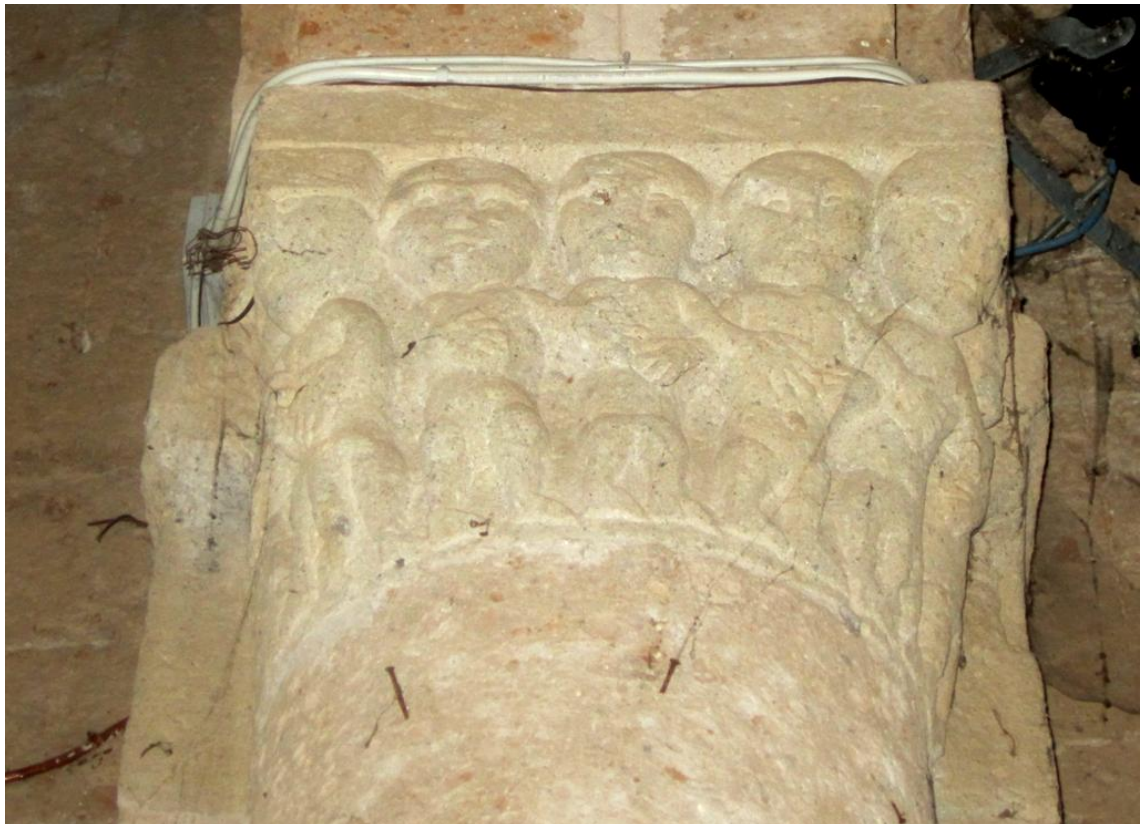
102. Castel Sant'Elia, basilica di Sant'Elia, controfacciata, particolare : capitello del semipilastro Sud.
