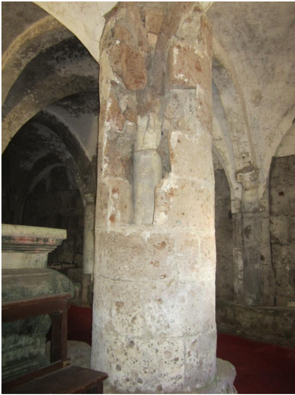
73. Castel Sant'Elia, basilica di Sant'Elia, cripta, pilastro con colonna all'interno.
