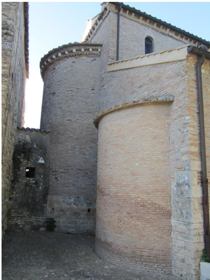
372. Ponzano Romano, abbazia di Sant'Andrea in flumine, absidi centrale ed Est.
