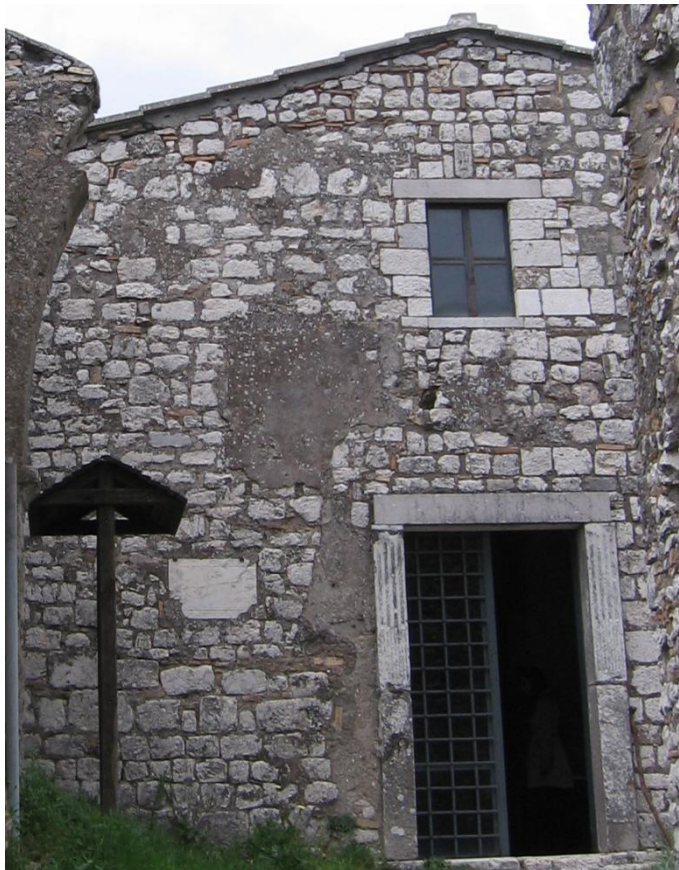
292. Sant'Oreste, monte Soratte, chiesa di San Silvestro, facciata, particolare della finestra e del portale.
