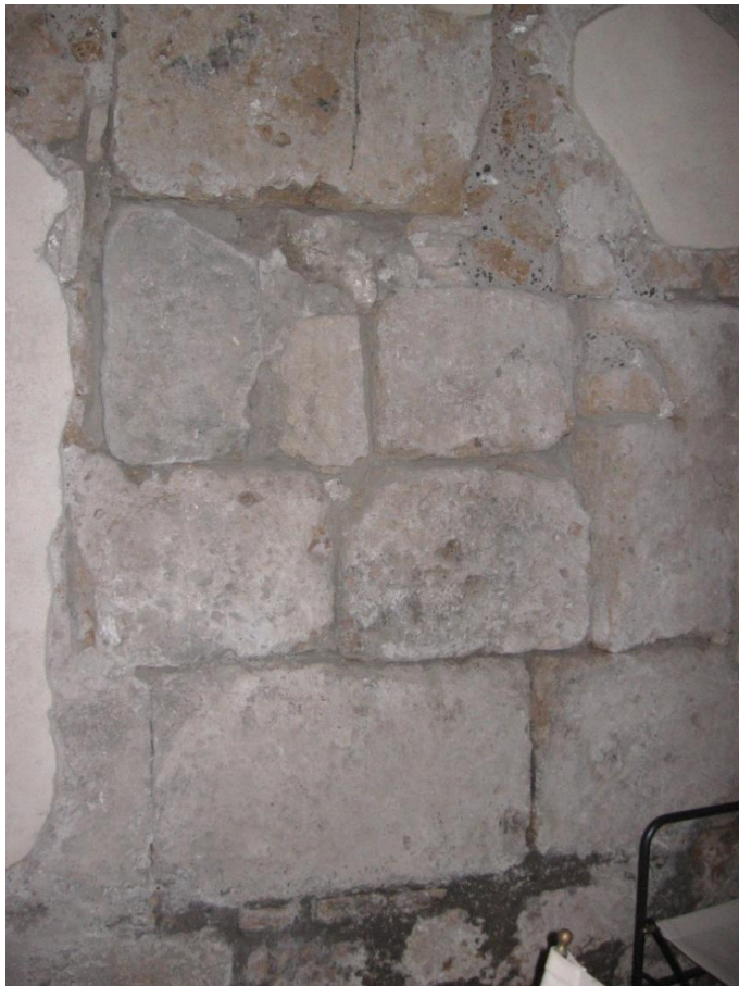
218. Nepi, chiesa di San Biagio, parete Sud, particolare della muratura.
