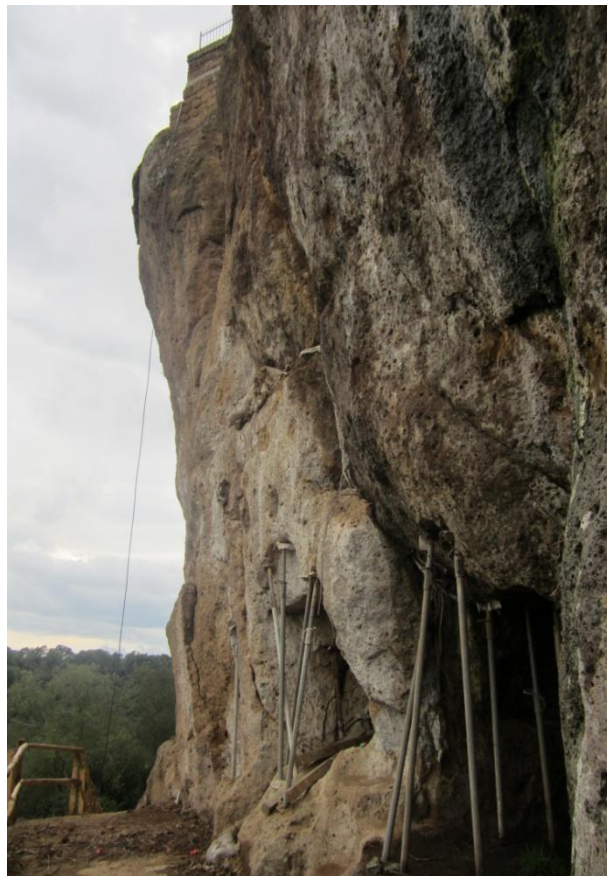
27. Castel Sant'Elia, sentiero per la grotta di San Leonardo: la rupe durante i lavori di puntellamento.
