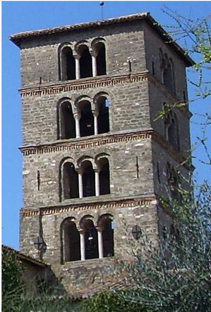
466. Fara in Sabina, abbazia di Farfa, torre campanaria.
