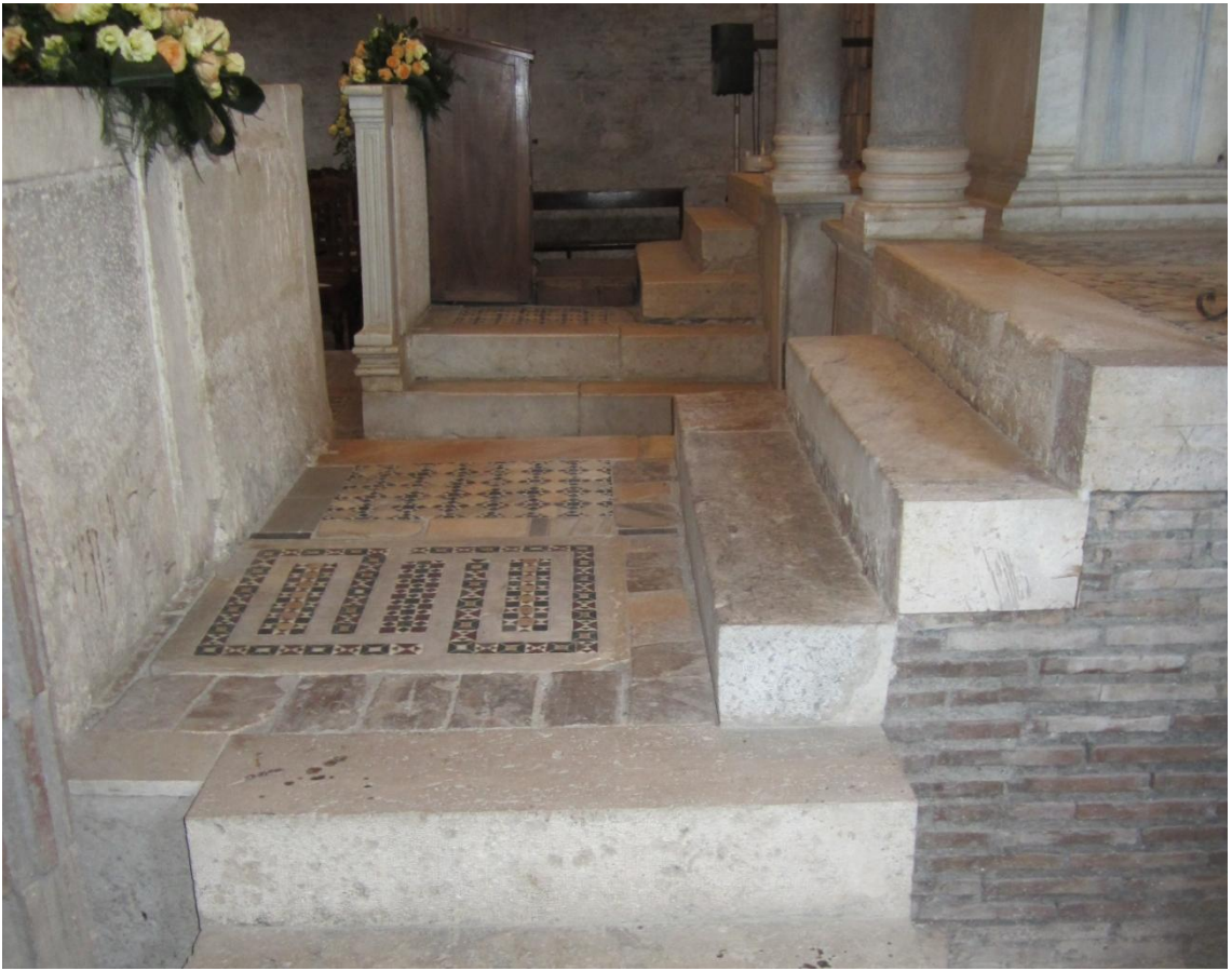
408. Ponzano Romano, abbazia di Sant'Andrea in flumine, abbaziale, presbiterio, pavimento cosmatesco, particolare.
