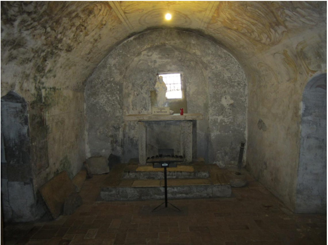
82. Castel Sant'Elia, basilica di Sant'Elia, sacello ipogeo, veduta verso Est.
