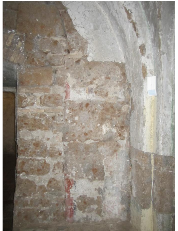
85. Castel Sant'Elia, basilica di Sant'Elia, cripta, parete Sud, particolare: porta tamponata e lacerti dipinti.
