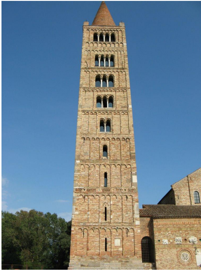
458. Codigoro, abbazia di Pomposa, torre campanaria.
