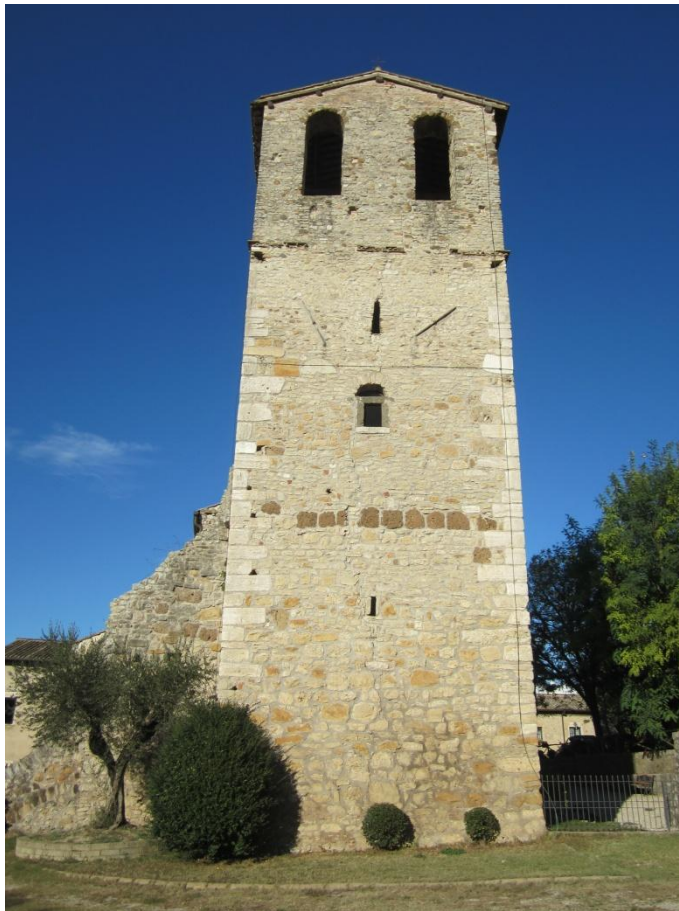
371. Ponzano Romano, abbazia di Sant'Andrea in flumine, torre campanaria, lato Sud.
