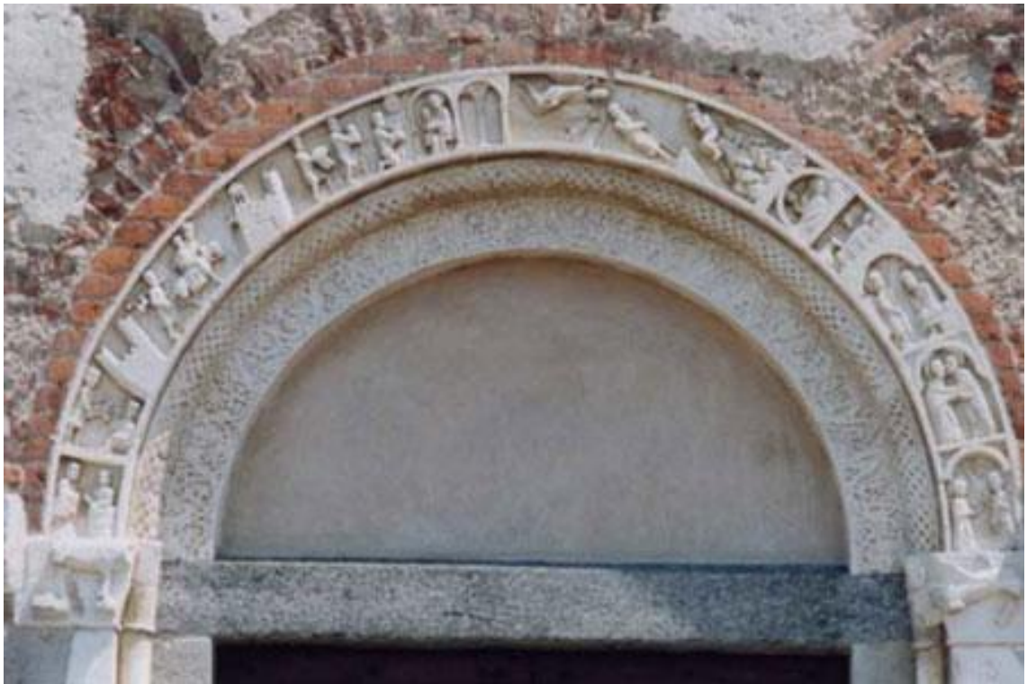
463. Melegnano, Santa Maria di Calvenzano, portale, particolare.
