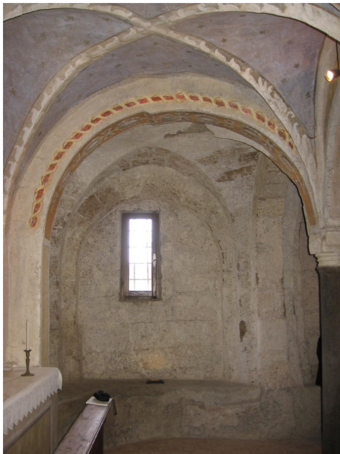
234. Nepi, chiesa di San Biagio, cripta, parete Sud, particolare.
