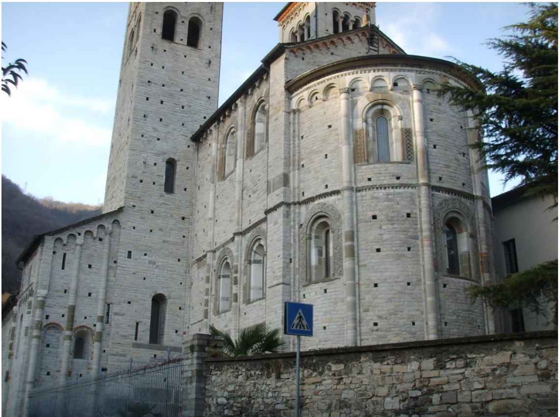
457. Como, basilica di Sant'Abbondio, abside.
