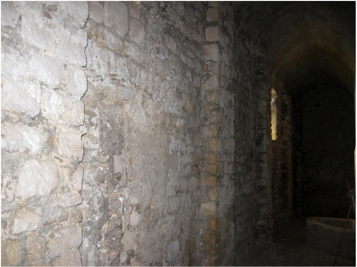
300. Sant'Oreste, monte Soratte, chiesa di San Silvestro, parete Sud.
