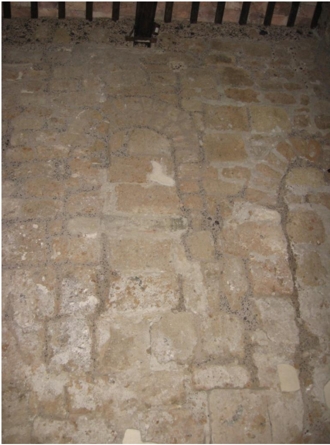
221. Nepi, chiesa di San Biagio, parete Sud, particolare.
