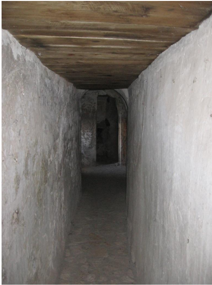
352. Sant'Oreste, monte Soratte, chiesa di San Silvestro, cripta, corridoio di collegamento con l'ambiente ipogeo.
