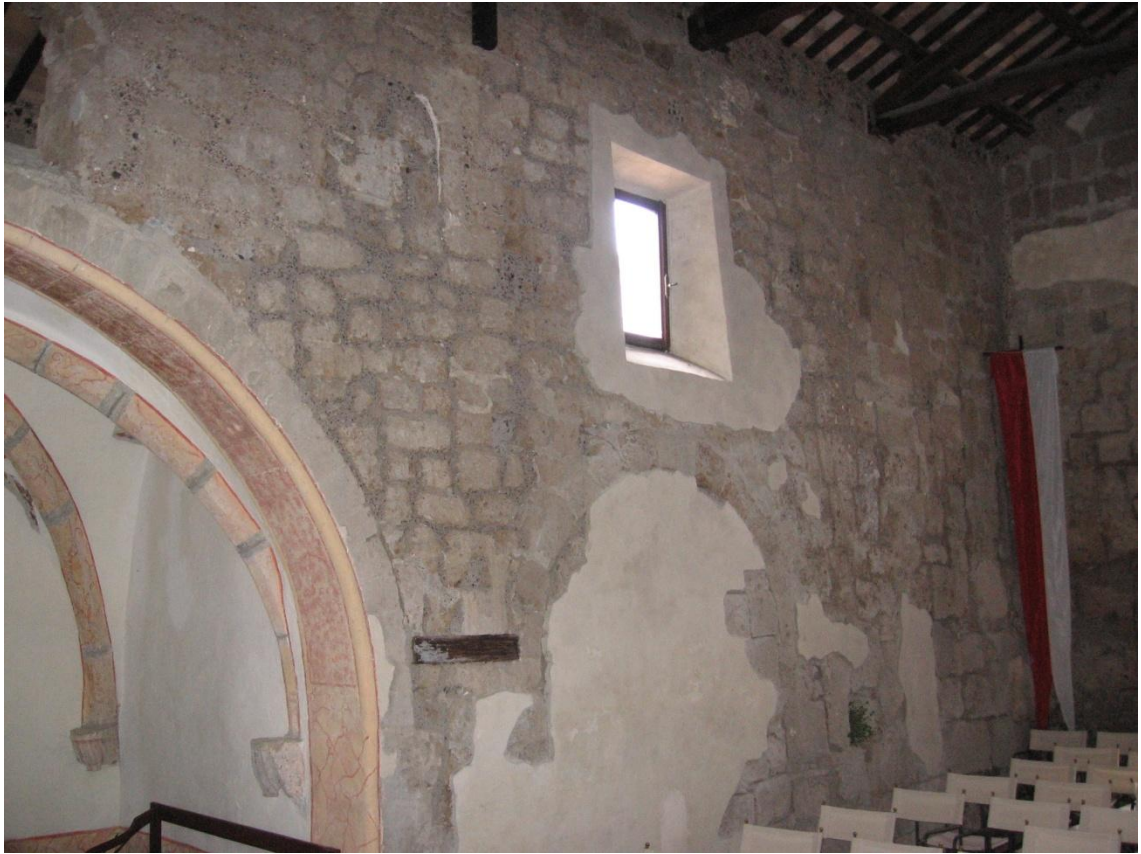
205. Nepi, chiesa di San Biagio, parete Sud, particolare.
