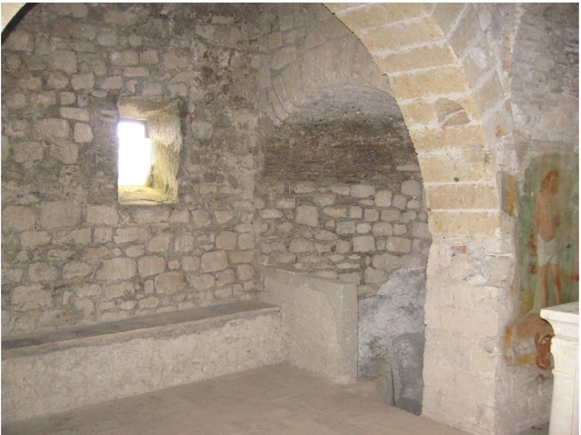
328. Sant'Oreste, monte Soratte, chiesa di San Silvestro, abside Sud.
