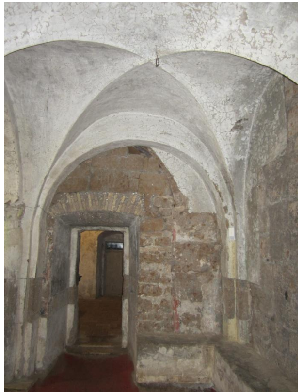
87. Castel Sant'Elia, basilica di Sant'Elia, cripta, parete Sud, particolare: porta tamponata e lacerti dipinti.
