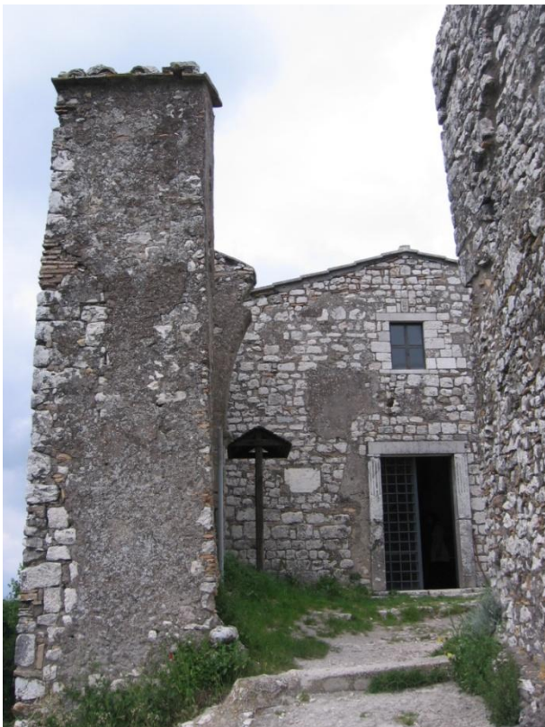
288. Sant'Oreste, monte Soratte, chiesa di San Silvestro, facciata e narteca, parete Sud.
