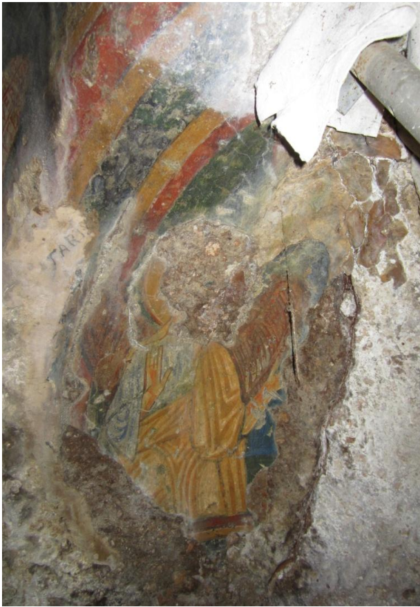
43. Castel Sant'Elia, grotta di San Leonardo, primo ambiente, parete Est, abside: angelo.
