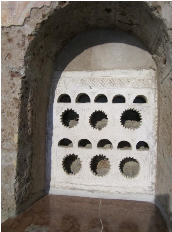
126. Castel Sant'Elia, basilica di Sant'Elia, transetto Sud, parete Est, transenna.
