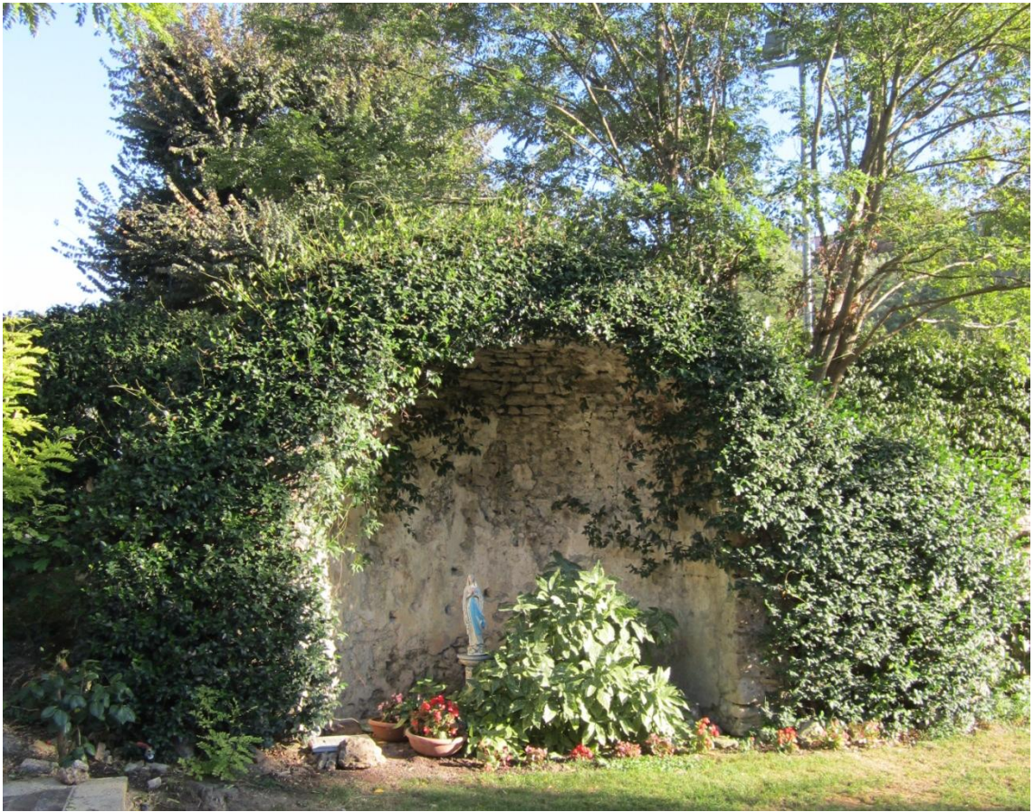
368. Ponzano Romano, abbazia di Sant'Andrea in flumine, cinta muraria, lato Est, abside.
