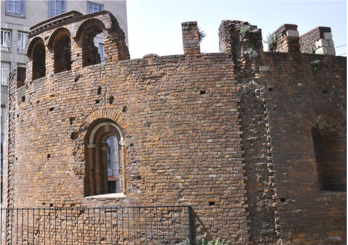
465. Milano, chiesa di San Giovanni in Conca, resti dell'abside.
