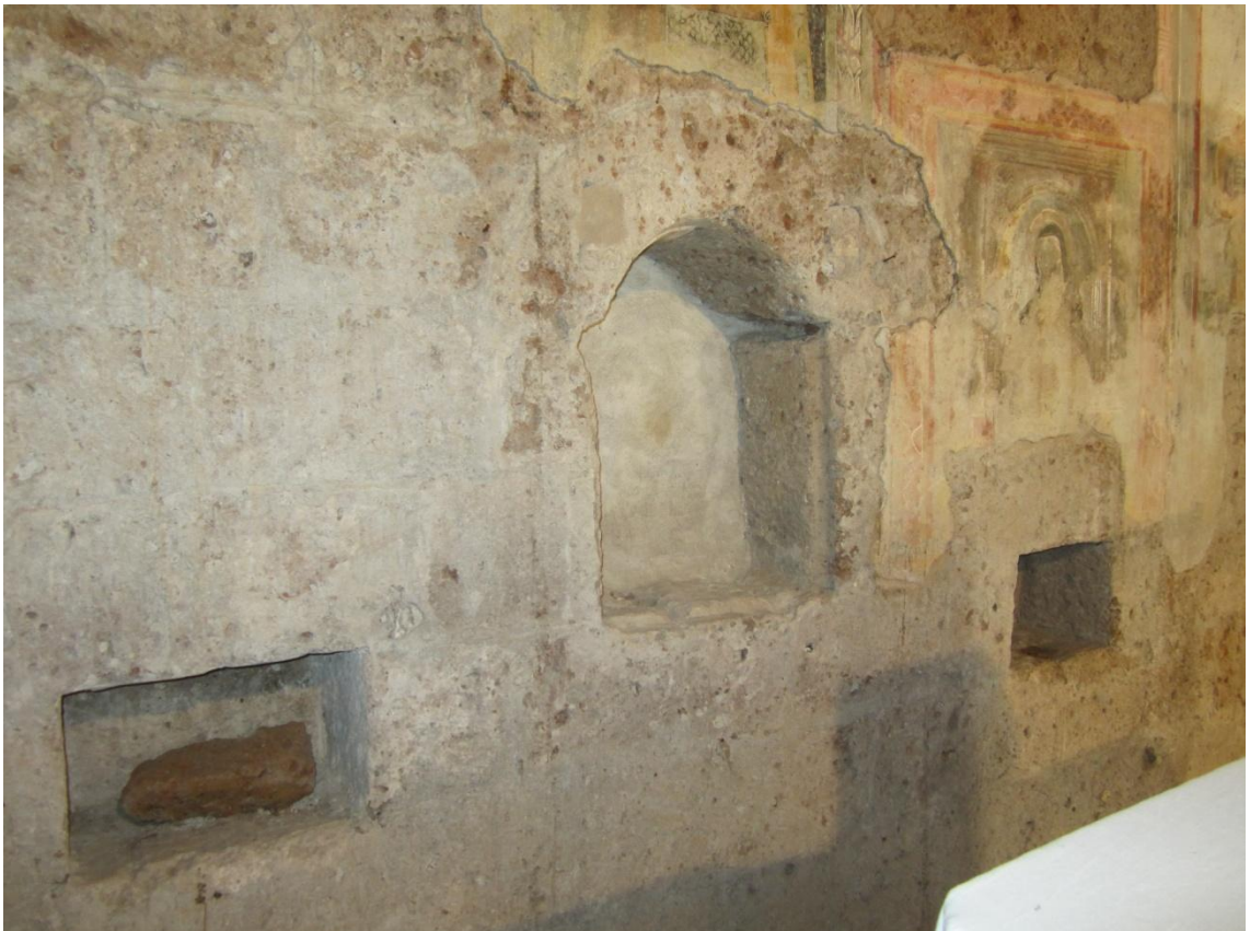
127. Castel Sant'Elia, basilica di Sant'Elia, transetto Nord, parete Est, nicchia.
