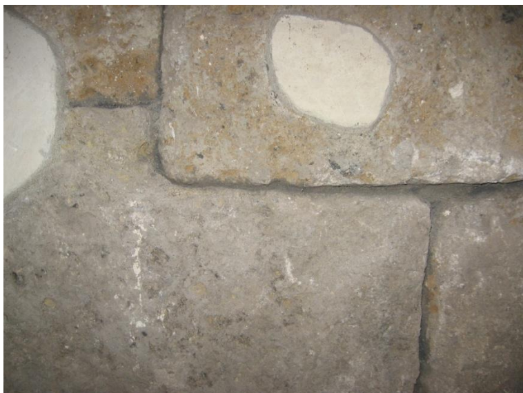
214-216. Nepi, chiesa di San Biagio, parete Nord, particolari della muratura.
