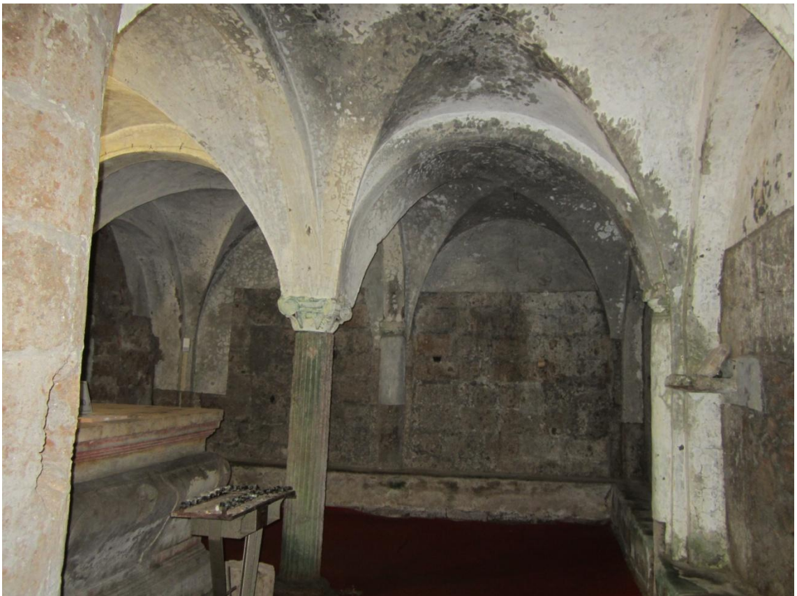
75. Castel Sant'Elia, basilica di Sant'Elia, cripta, veduta verso Ovest.
