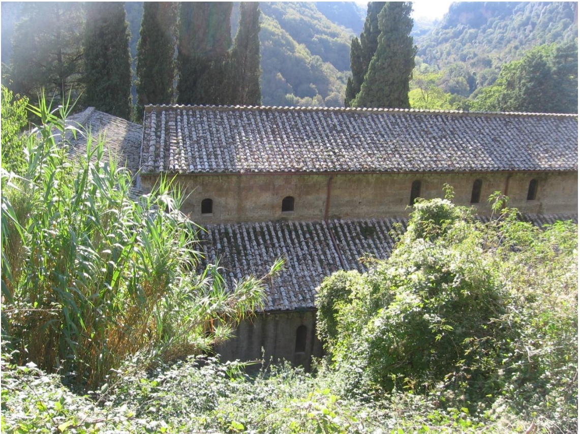
62. Castel Sant'Elia, basilica di Sant'Elia, fianco Nord.
