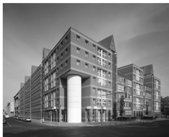
43 – Aldo Rossi, edificio per abitazioni a Berlino
