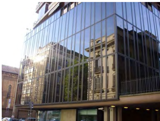
Fig. 202 – Edificio Polifunzionale a via Campania – Zona degli uffici.
