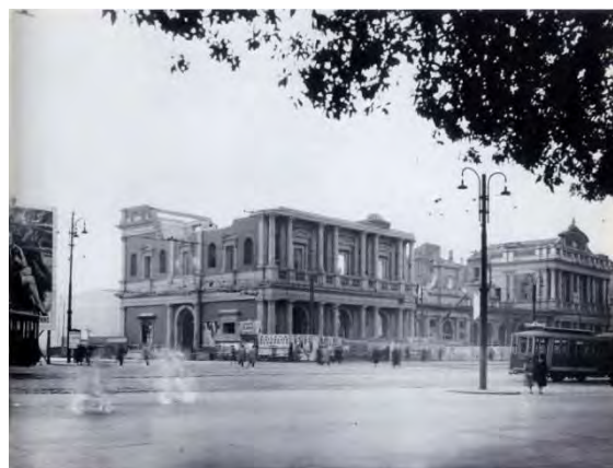
Fig. 69 – “Il fronte dell’ala sinistra stato attaccato”, l’orologio rimosso, la pensilina smontata Stazione di Roma Termini – dicembre 1948.
