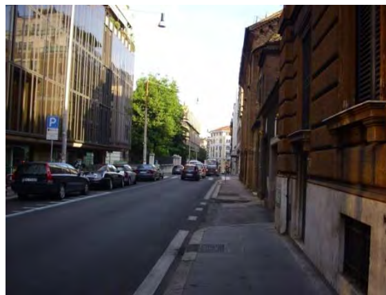
Fig. 218 - Edificio Polifunzionale in via Campania: Il contesto.
