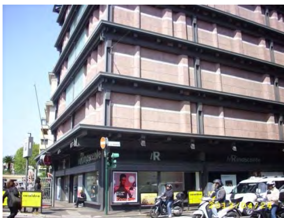
Fig. 119 – La Rinascente a Piazza Fiume - Pannelli prefabbricati leggeri in graniglia di granito e marmo rosso.
