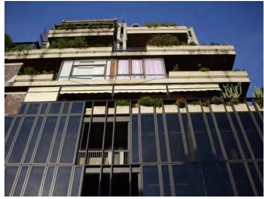
Fig. 195 – Edificio Polifunzionale a via Campania
