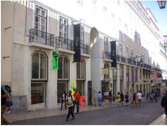
Fig. 247 – Lisbona: fronte su Rua do Carmo Progetto.
