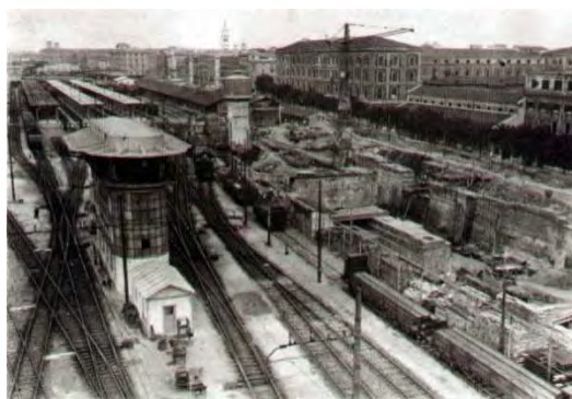
Fig. 35 – Stazione di Roma Termini – Scavo per la costruzione del fabbricato «B» del progetto Mazzoni lungo la via Marsala. Giu. 1930.
