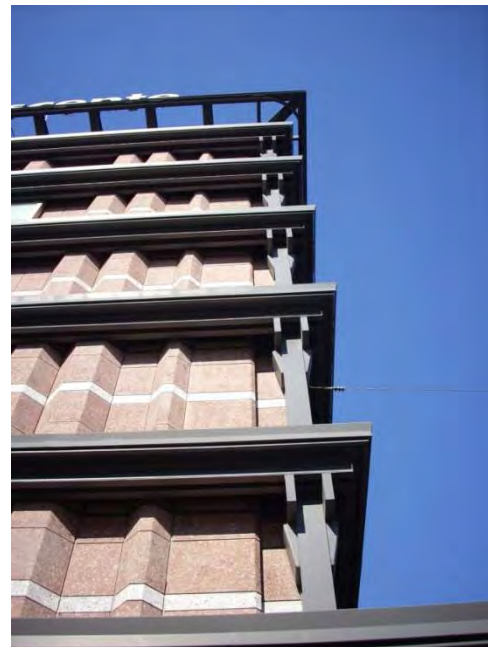
Fig. 137 – La Rinascente a Piazza Fiume – Contrasto tra struttura e tamponamento
