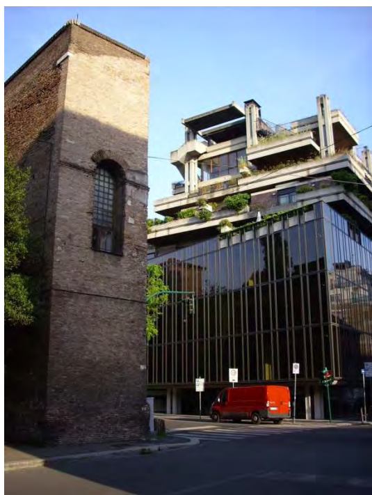
Fig. 203 – Edificio Polifunzionale a via Campania - La zona commerciale a piano terra
