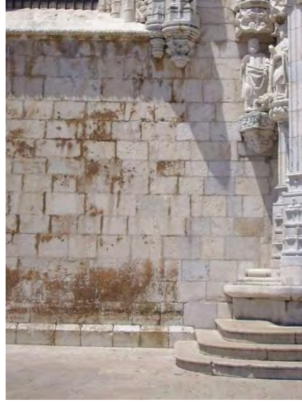
Fig. 261 – Centro Culturale di Belém - Dettaglio Foto dell'autore – Giugno 2012
