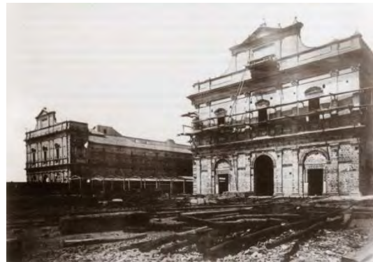
Fig. 43 – Il progetto di Salvatore Bianchi – 1867. I prospetti posteriori in corso di costruzione.
