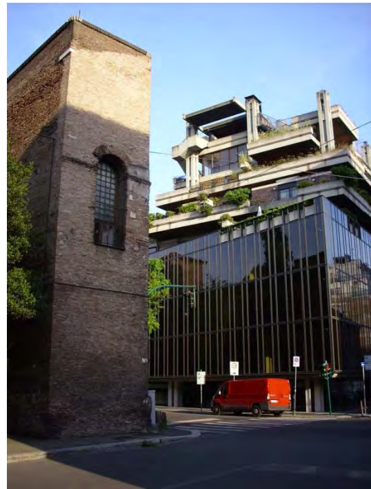
Fig. 191 – Edificio Polifunzionale a via Campania.
