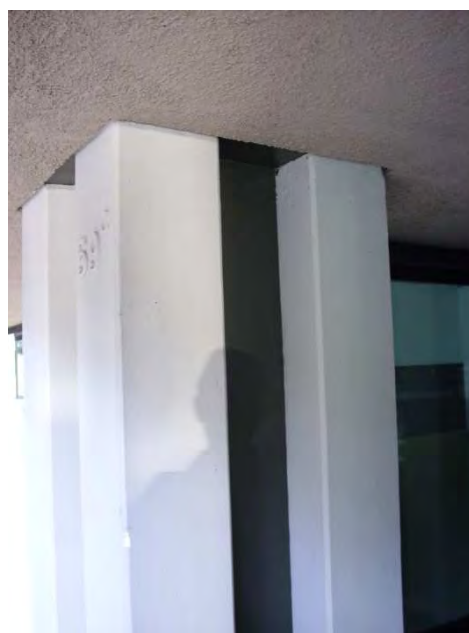
Fig. 215 – Edificio Polifunzionale in via Campania - Pilastrini a quadrifoglio per i piani in elevazione.
