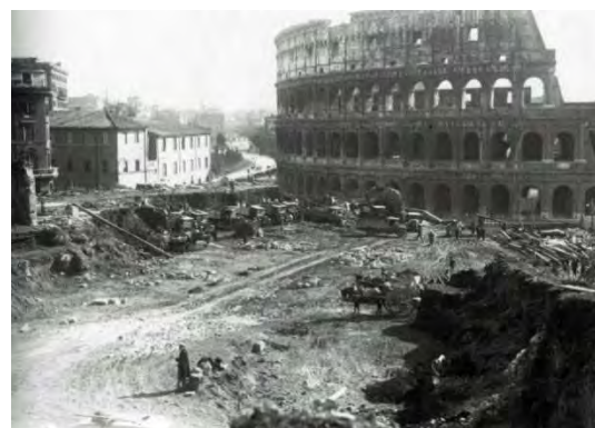
Fig. 19– La demolizione della collina della Velia verso il Colosseo, febbraio 1932.
