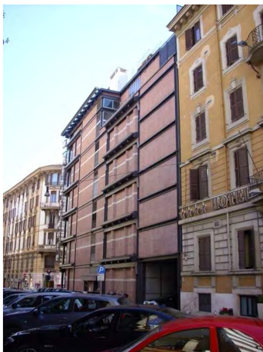
Fig. 129 – La Rinascente a Piazza Fiume – Le scale di sicurezza su via Aniene contenute nel prospetto.
