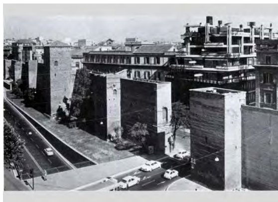
Fig. 213 – Edificio Polifunzionale a via Campania – Le strutture verticali e i torrioni di guardia.
