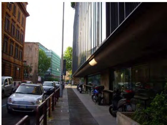
Fig. 201 – Edificio Polifunzionale a via Campania - La zona commerciale a piano terra
