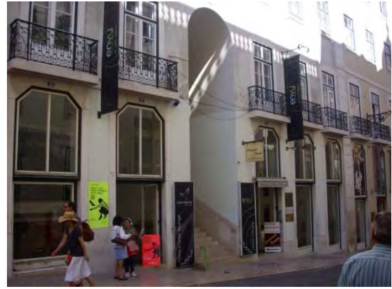
Fig. 248 – Lisbona: fronte su Rua do Carmo Progetto.
