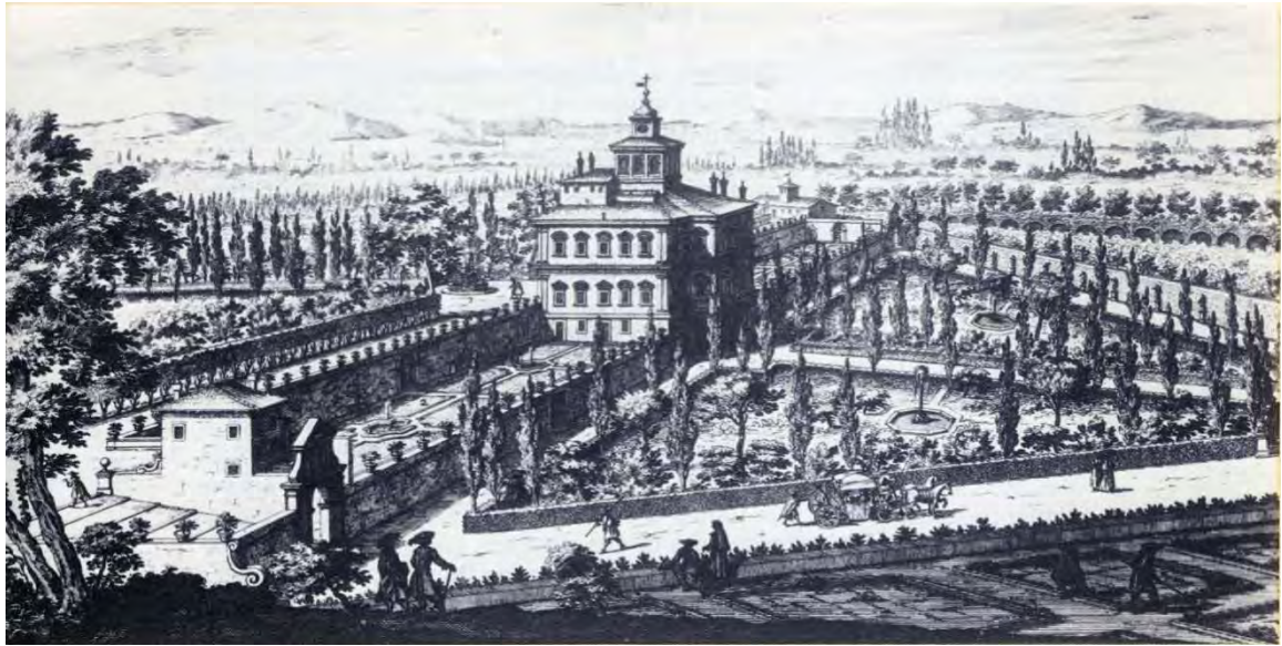
Fig. 41 – Veduta della Villa Massimo dal lato delle Terme.
