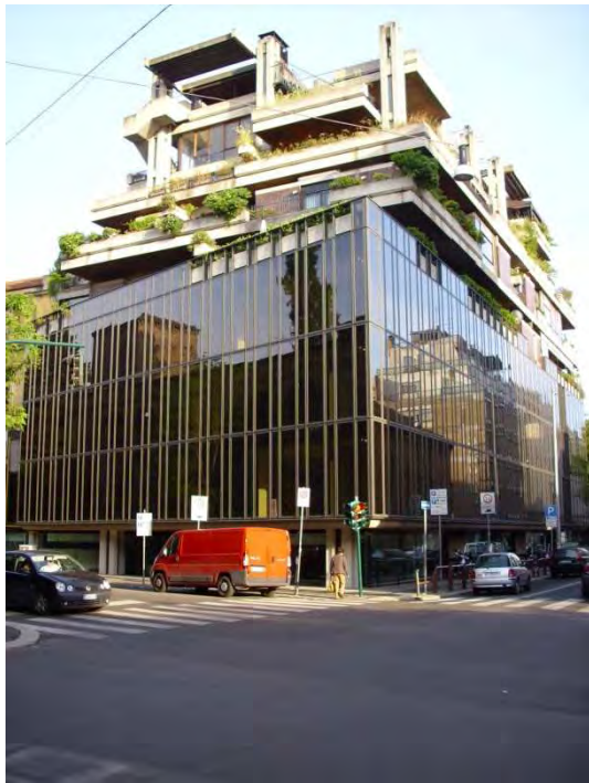
Fig. 190 – Edificio Polifunzionale a via Campania.
