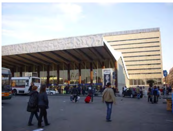
Fig. 94 – Fronte principale della Testata della Stazione Termini. Vista angolo via Giolitti Piazza dei Cinquecento.
