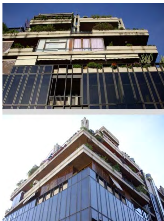
Fig. 204 – Edificio Polifunzionale a via Campania – Zona degli uffici.
