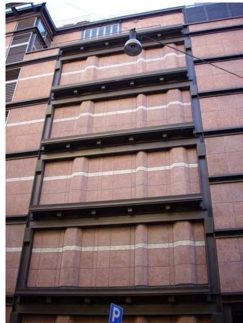
Fig. 135 – La Rinascente a Piazza Fiume – Angolo Piazza Fiume via Salaria
