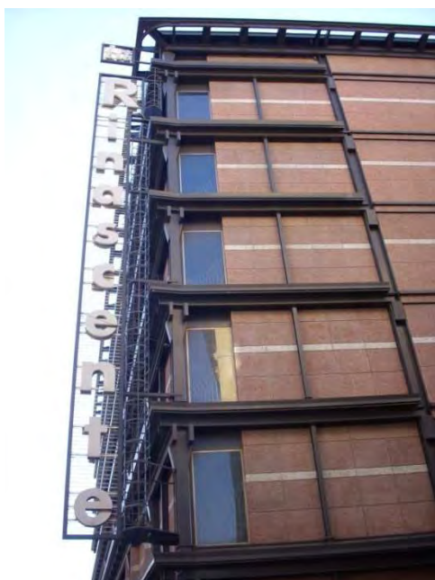
Fig. 122 – La Rinascente a Piazza Fiume – Rotaia per il carrello di pulizia della facciata.
