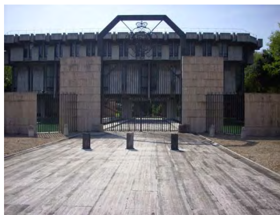
Fig. 185 – Ambasciata Britannica – Portale di ingresso all'ambasciata
