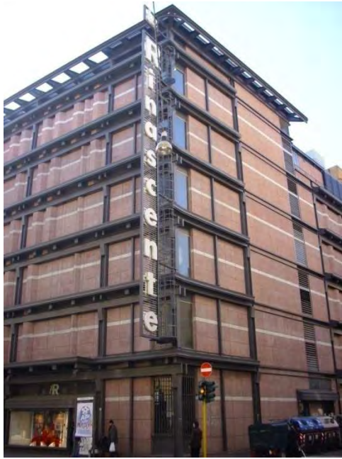
Fig. 134 – La Rinascente a Piazza Fiume – Angolo via Salaria via Aniene
