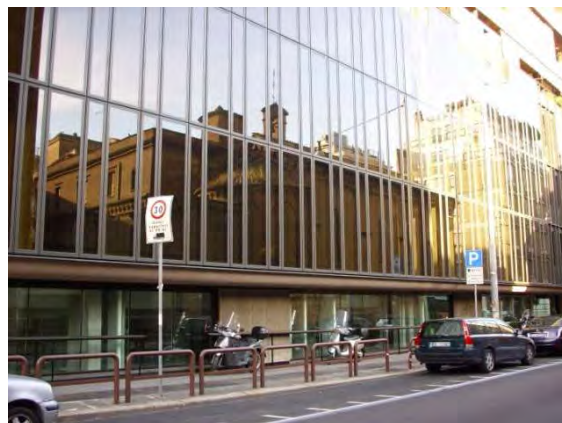
Fig. 199 – Edificio Polifunzionale a via Campania
