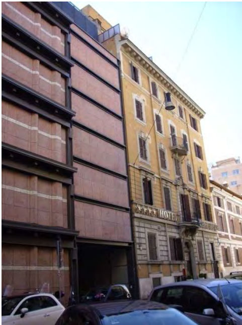
Fig. 140 – La Rinascente a Piazza Fiume – Tamponamento e maglia metallica si chiusura del blocco su via Aniene.
