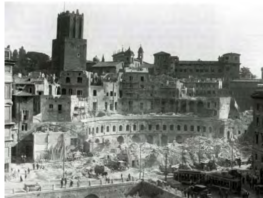
Fig. 18– Lavori per la liberazione dell'edera dei Mercati Traianei, guardando verso la Torre delle Milizie, ottobre 1929.
