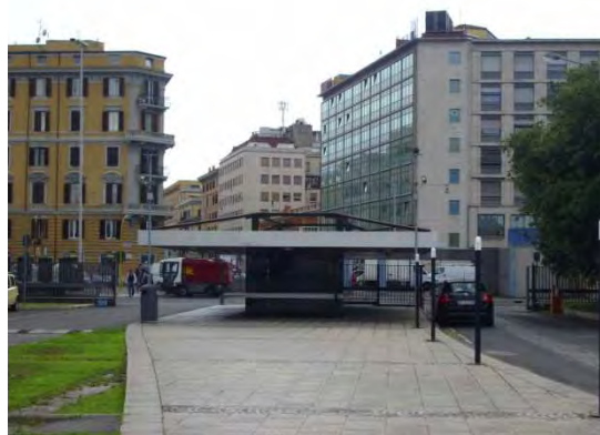
Fig. 166 – La Biblioteca Nazionale Centrale Vittorio Emanuele II – Mura Aureliane su tre lati del lotto di intervento.
