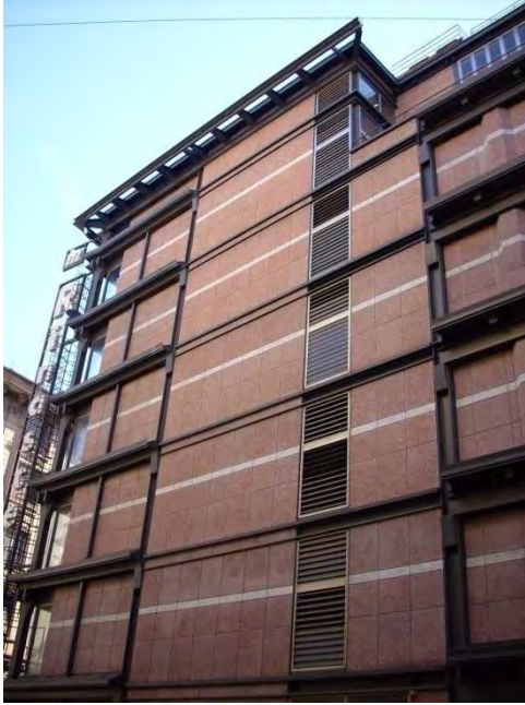
Fig. 138 – La Rinascente a Piazza Fiume – Pannelli di tamponamento rosso carminio.
