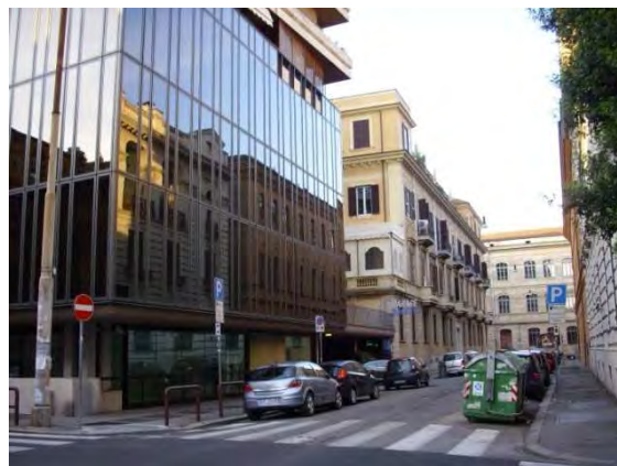
Fig. 209 – Edificio Polifunzionale a via Campania – Superficie a specchio per le mura Aureliane.
