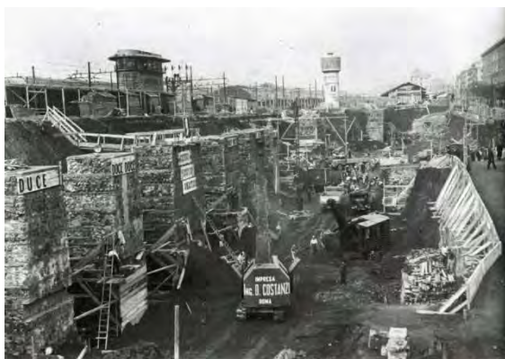
Fig. 64 – Lavori di costruzione della nuova Stazione di Roma Termini – dicembre 1938.
