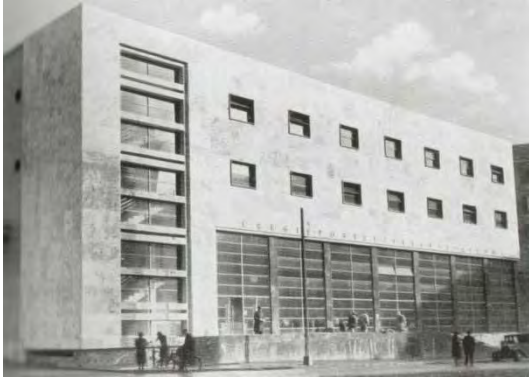
Fig. 23 – Il palazzo delle Poste al quartiere Appio (Via Taranto-Via Pozzuoli) – Giuseppe Samonà – 1933-1936.
