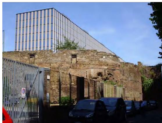
Fig. 165 – La Biblioteca Nazionale Centrale Vittorio Emanuele II – Mura Aureliane su tre lati del lotto di intervento.
