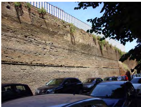
Fig. 164 – La Biblioteca Nazionale Centrale Vittorio Emanuele II – Mura Aureliane su tre lati del lotto di intervento.
