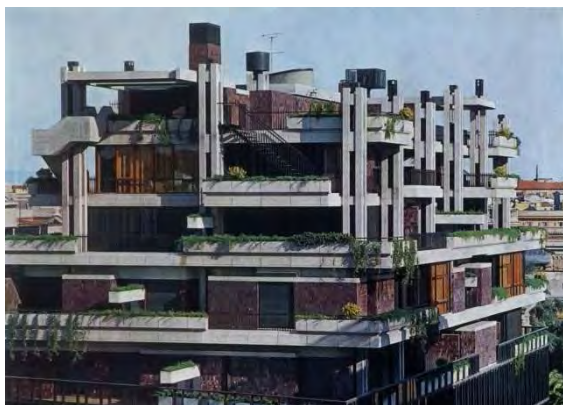
Fig. 212 – Edificio Polifunzionale a via Campania – Le strutture verticali.
