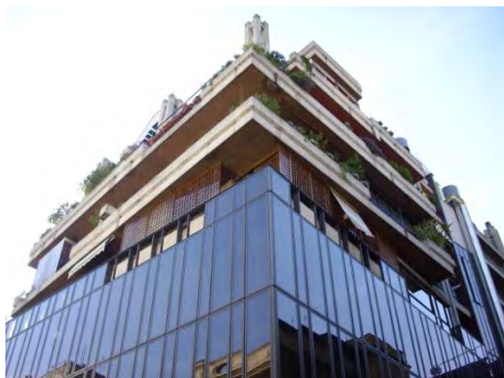
Fig. 198 – Edificio Polifunzionale a via Campania e il polilinguismo
