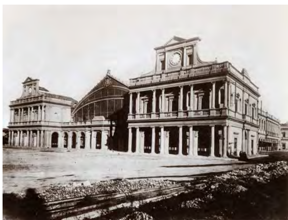
Fig. 46 – Il progetto di Salvatore Bianchi – 1867 Il fabbricato pressoché ultimato.
