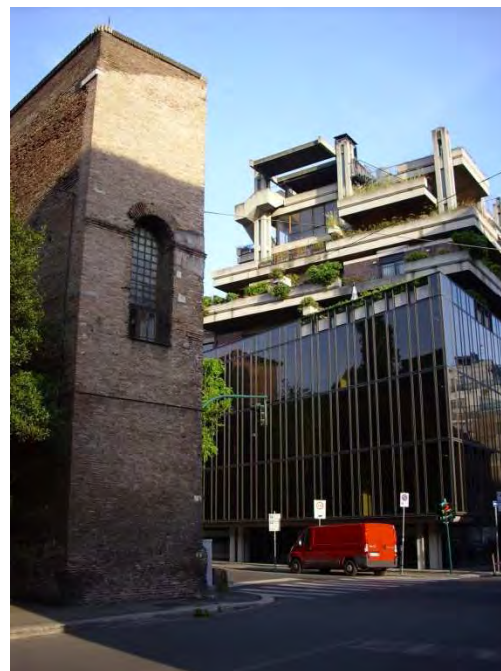
Fig. 206 – Edificio Polifunzionale a via Campania – Superficie a specchio per le mura Aureliane.
