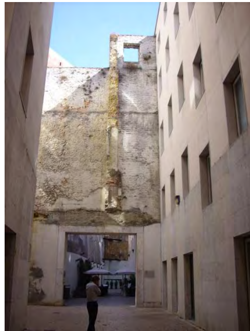
Fig. 250 – Lisbona: fronte su Rua do Carmo Progetto.
