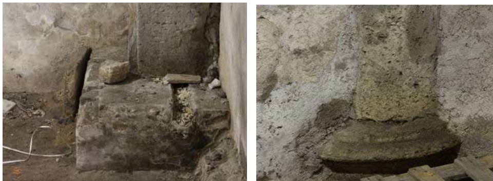
figg. 46 - 47- Palazzo Pamphili (Ambasciata del Brasile). Particolari delle basi di pilastri in travertino (foto S.Caiola).
