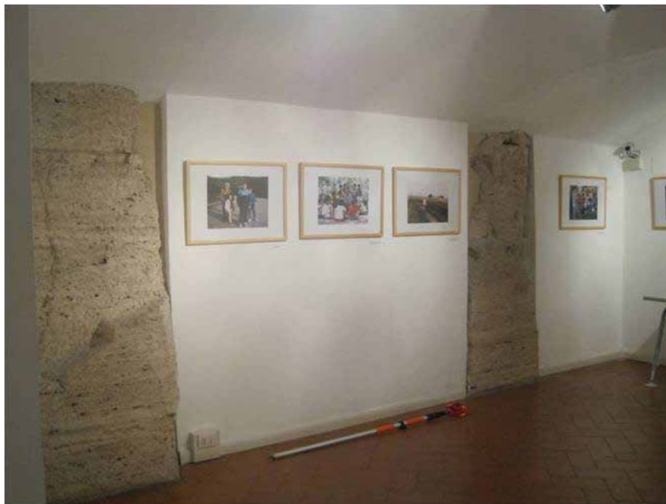
fig. 50 - Istituto 'Cervantes', livello interrato, resti di pilastri dello Stadio di Domiziano nell'area espositiva. Il travertino si presenta molto alveolizzato, soprattutto nella parte bassa (foto B. Buonomo).
