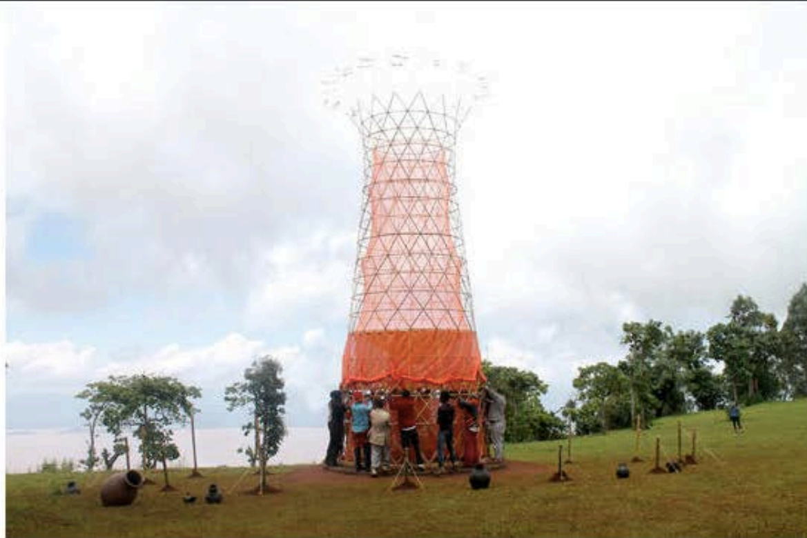
Warka Water. Il progetto di Arturo Vittori Architecture and Vision per raccogliere la rugiada notturna
