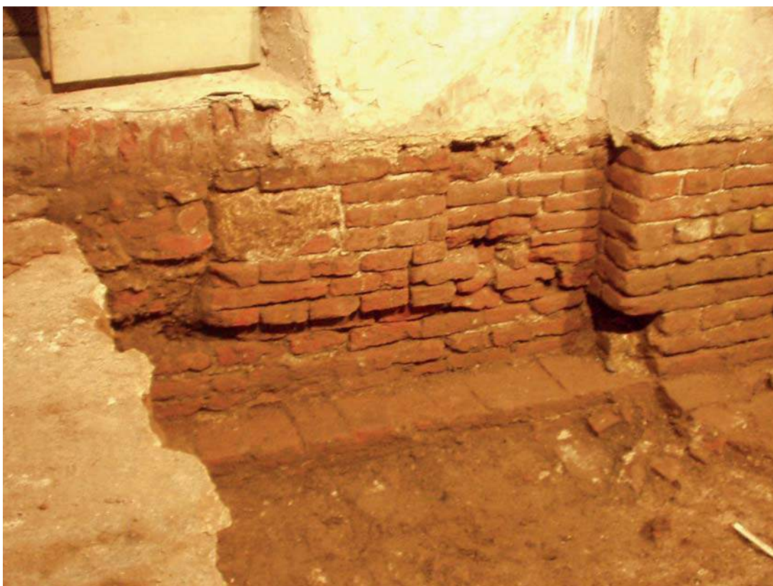
Fig.4 - Fondazioni delle murature del lato Est del saggio (Attività 4).
