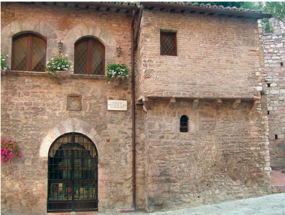
Fig. 17a. Assisi, via San Francesco. Loggia dei maestri commacini: generale e dettaglio con la data di costruzione o restauro (foto A. Sereni).
