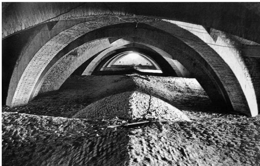
Fig. 5. Assisi, Basilica Superiore di San Francesco: il sottotetto all'inizio degli anni Ottanta del Novecento. Al centro della foto è chiaramente visibile il livello raggiunto dai riempimenti addossati alle volte (da Rocchi, La basilica di San Francesco ad Assisi , fig. 60 fuori testo).
