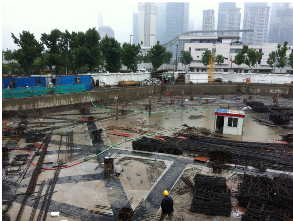
Figura 5.10: Foto del cantiere nella situazione che precede la costruzione del primo livello di supporto (scattata il 27/06/2012, gentilmente concessa dall'Ing. Chen HongWei).
