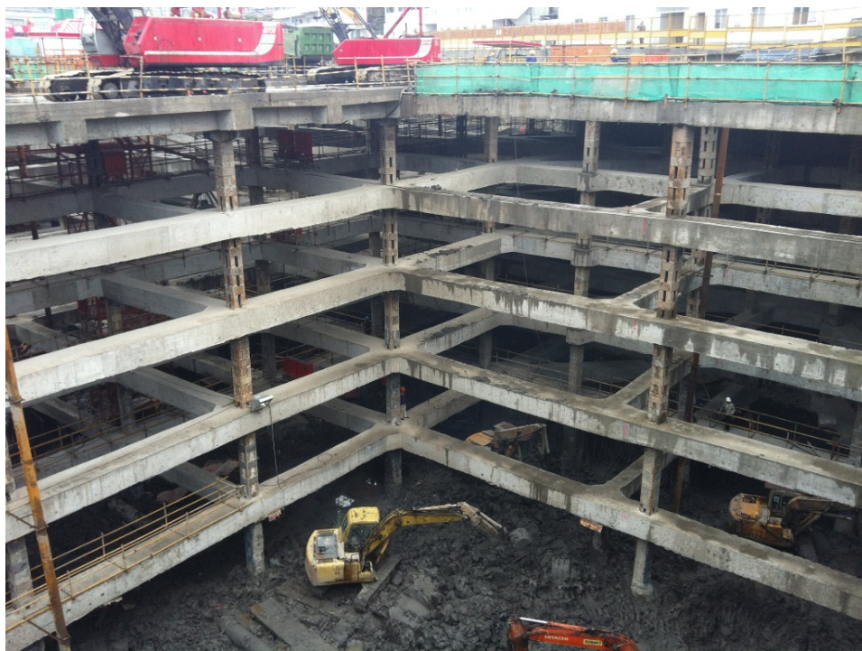
Figura 5.14: Foto del cantiere a scavo quasi ultimato (scattata il 09/11/2012, gentilmente concessa dall'Ing. Chen HongWei).
