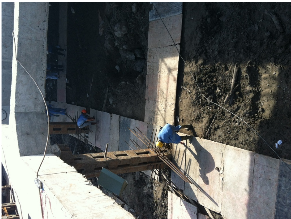
Figura 5.12: Foto del cantiere nel momento in cui ci si prepara alla realizzazione del secondo livello di supporto (scattata il 17/08/2012, gentilmente concessa dall'Ing. Chen HongWei).
