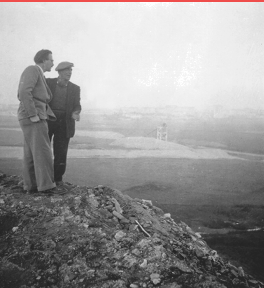
Milano 1951 - QT8 - Piero Bottoni e Fernad Leger sul Monte Stella in costruzione
