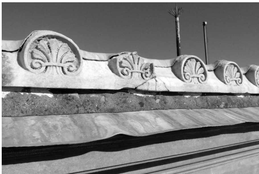
Figura 11 – Roma, Cortile del Belvedere, loggia del Nicchione, particolare della cornice dell'attico (foto Antonella Festa).
