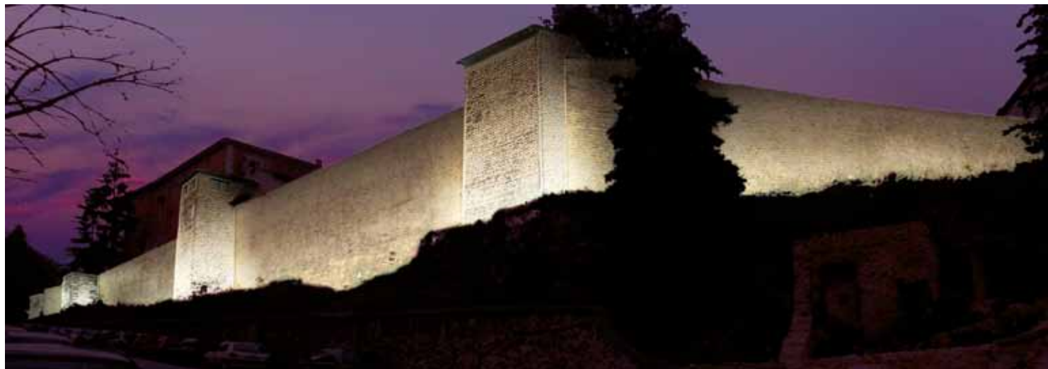
Fig. 1. L'Aquila, medieval city walls
