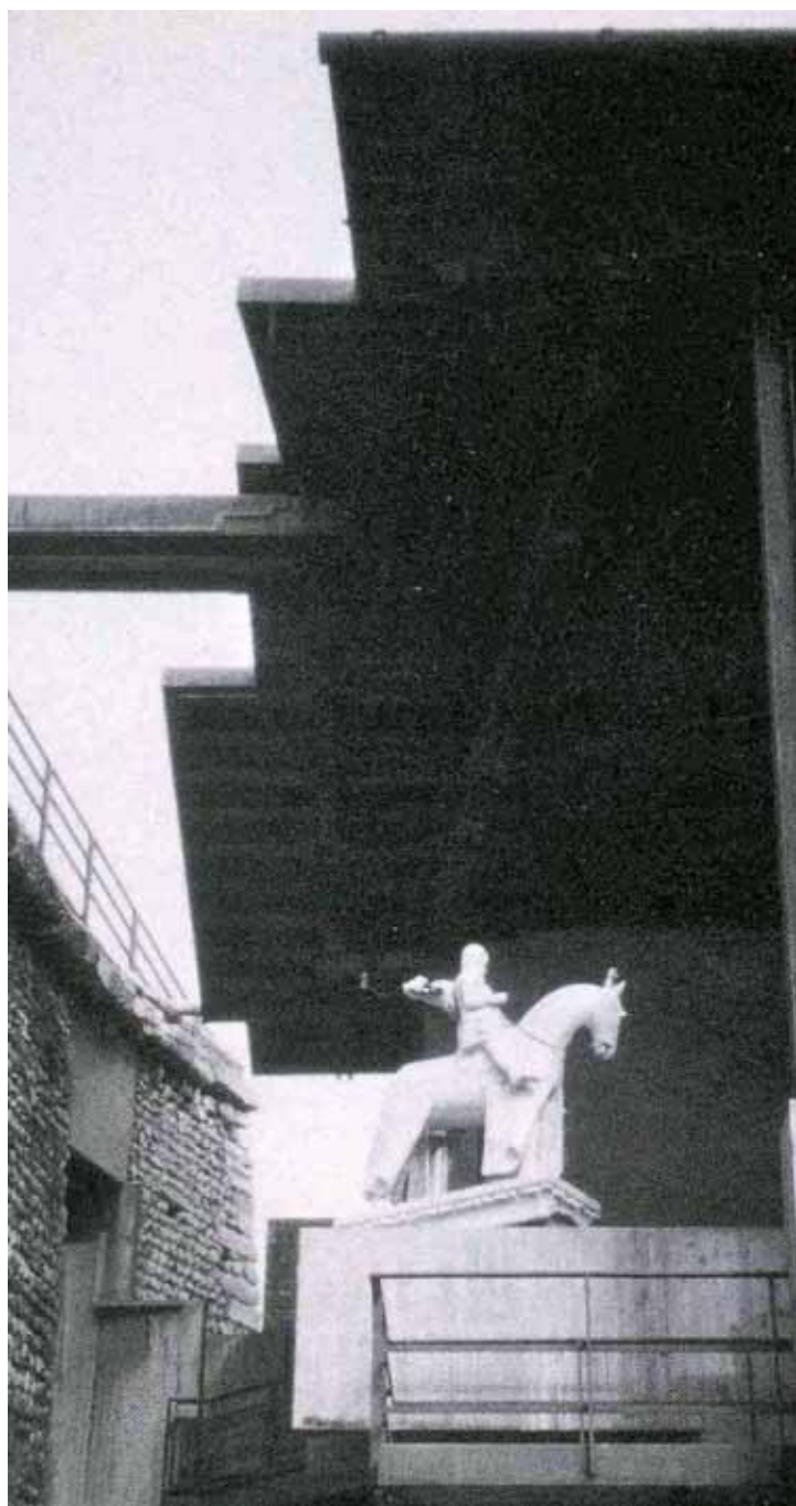
Fig. 6. The roof protecting the sculpture designed by Carlo Scarpa. Рис. 6. Защитное перекрытие скульптуры работы Карло Скарпа.
