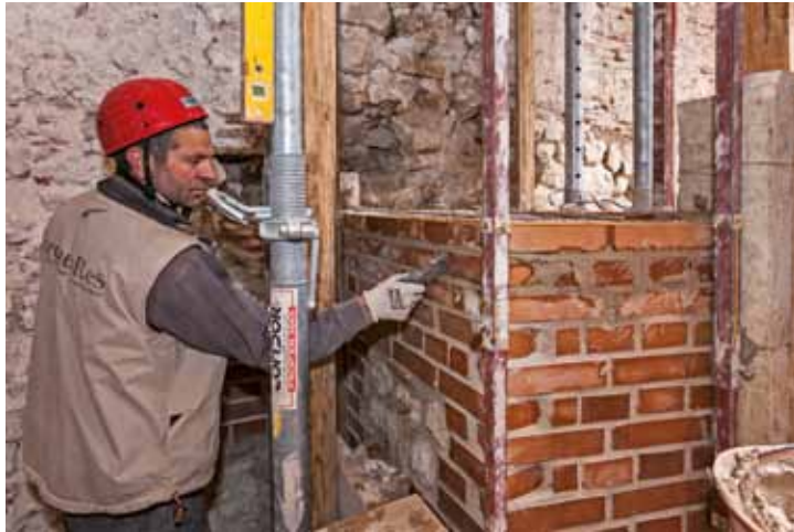
Fig. 3. Repair of damages by “scuci-cuci” technique on a brick wall. Рис. 3. Устранение повреждений и реставрация кирпичной стены техникой вычинки.
