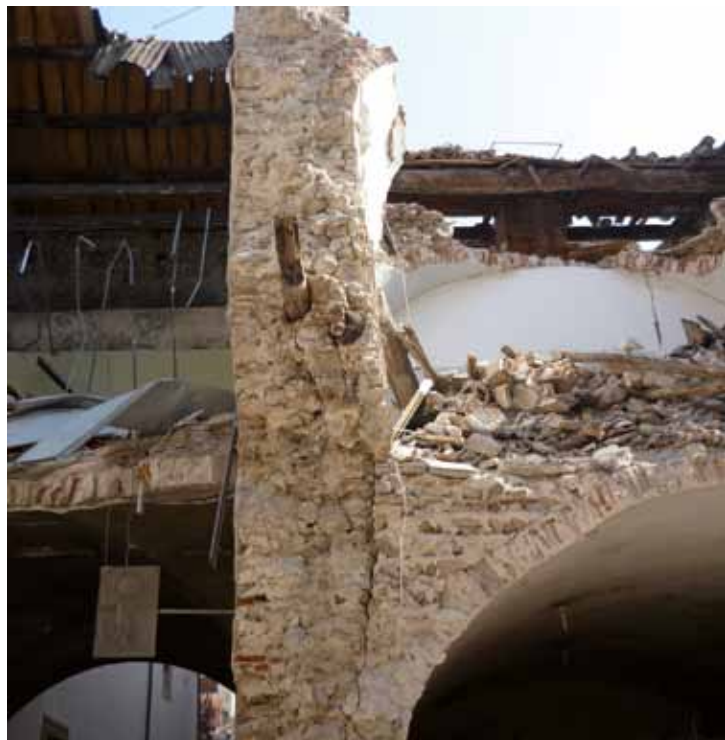
Fig. 1. L'Aquila. Wooden log (radiciamento) embedded in a shear wall.
