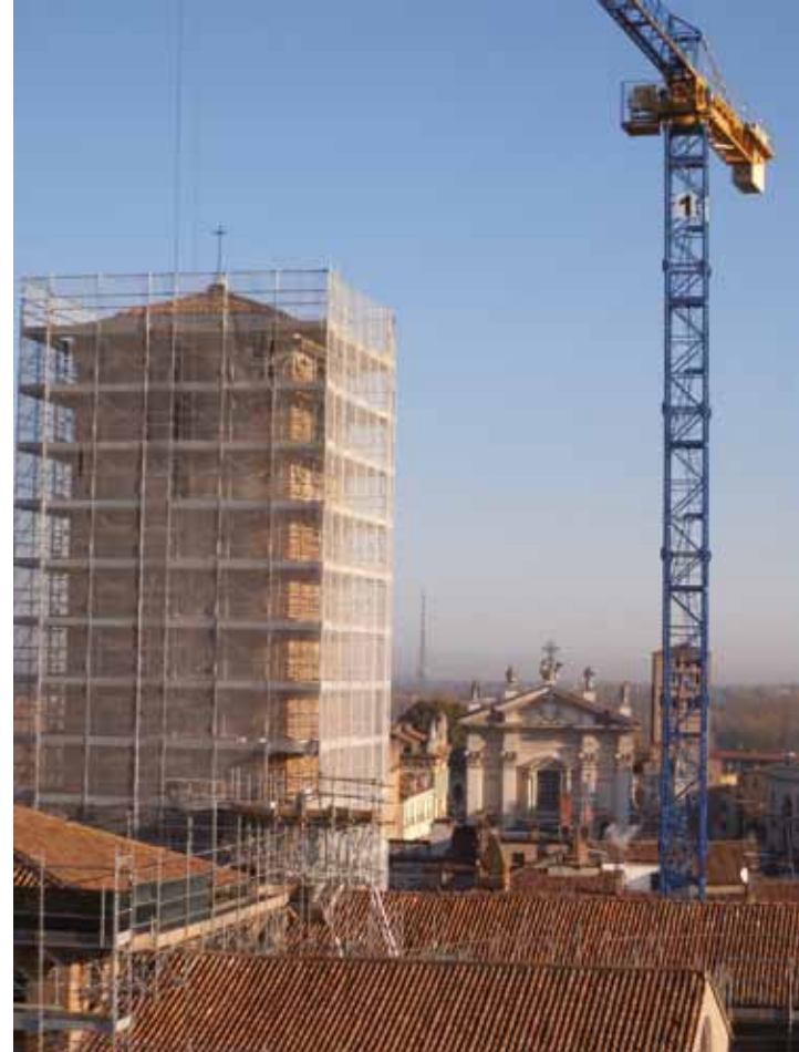
Fig. 2. Securing works of Torre delle Ore, Palazzo del Podestà.
