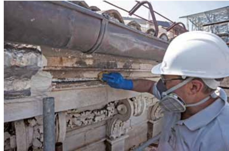
Fig. 4. Restoration of the eaves with decorative elements in stucco and stone. Рис. 4. Реставрация декоративной штукатурки и камня карнизов.
