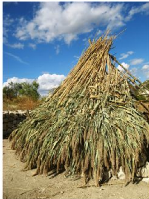
Fig.4: La copertura in cannuce in corso di realizzazione.
