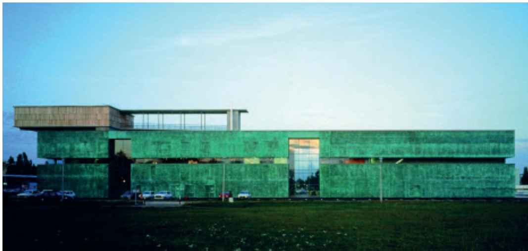
Immagine n. 2: Bordeaux, Maison des Arts, immagine tratta dal sito http://www.fuksas.it/it/Progetti/Maison-des-Arts-Universit%C3%A0-Michel-de-Montaigne-Bordeaux .
