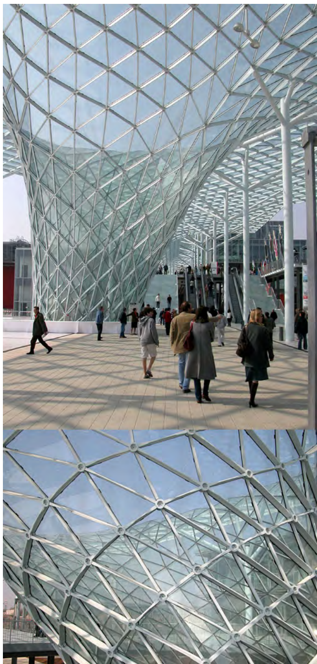
I.7/ Massimiliano Fuksas, copertura della nuova Fiera di Milano, 2002-2005.
