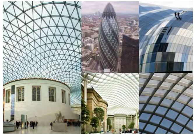
I.1/ Molte architetture di Foster fanno uso della riduzione ad elementi discreti delle superfici.
