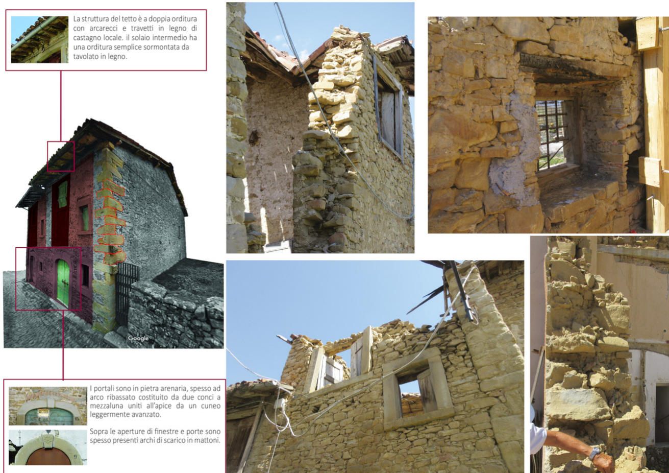
Fig. 7 Indagine a vista degli edifici limitrofi al caso studio rimaneggiati dall'evento sismico.
