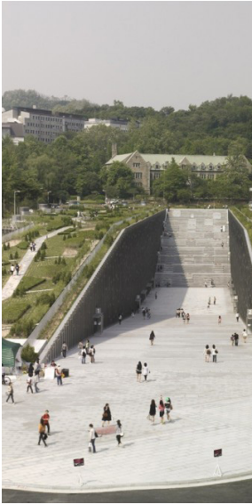
Fig.1 Vista frontale dell'edificio
