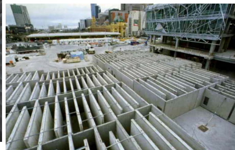
Fig.11 Costruzione del labirinto d'aria termico
