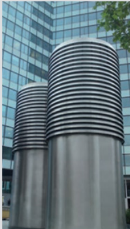
Fig.1_ Torri di ventilazione cilindriche in acciaio inox con testa a lamelle orizzontali, integrate nel contesto architettonico urbano. Fonte: Top Air G.m.b.H. (2021). Torri di ventilazione. https://www.top-air.it/it/Produkte/torri-di-ventilazione/
