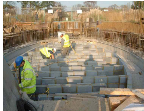
Fig.9 Vista di cantiere di una struttura interrata in costruzione, con pareti in calcestruzzo e setti disposti in sequenza per formare un sistema articolato di percorsi
