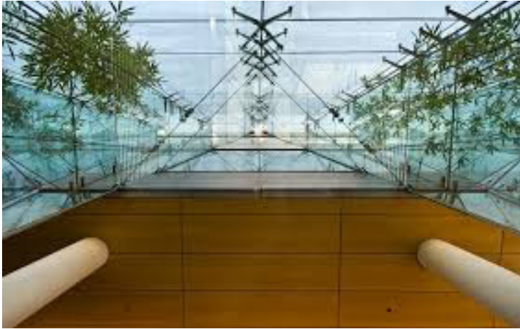
Figura 4.34 Surry Hills Library and Community Centre, dettaglio dello spazio interno con copertura vetrata e sistema di ventilazione naturale zenitale, progettato per favorire l'illuminazione diffusa e il controllo termo-ambientale passivo degli ambienti collettivi. Fonte: Inhabitat, Surry Hills Library: Australia's new standard of sustainable excellence.
