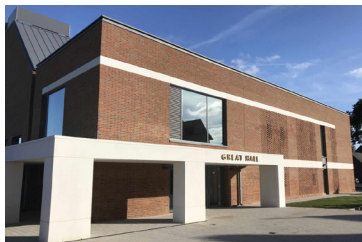
Figura 4.1 Vista esterna della Great Hall del Kent College di Canterbury. L'edificio presenta un involucro in laterizio caratterizzato da superfici compatte e da pannellature traforate che contribuiscono alla modulazione dell'illuminazione naturale e alla ventilazione dell'involucro. Fonte: HMY Architects, The Great Hall – Kent College Canterbury.
