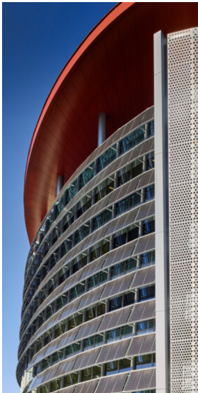
Fig.2 Vista della facciata posteriore dell'edificio
