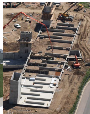
Fig.9 Fase di costruzione. L'immagine evidenzia la realizzazione delle strutture in calcestruzzo e degli elementi lineari del sistema ipogeo di ventilazione, utilizzati per il preriscaldamento dell'aria attraverso lo
