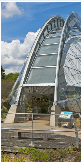
Fig.2 Ingresso alla struttura
