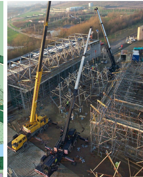
Fig.7 Immagine della costruzione dell'edificio e della pensilina solare
