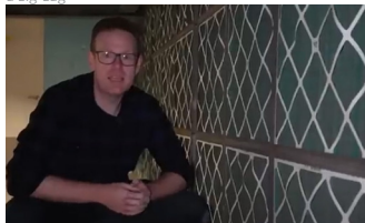
Fig.7 Sistema di filtraggio dell'aria attraverso i cardboard filter prima dell'ingresso nel labirinto termico e dettaglio dell'elemento filtrante dell'aria
