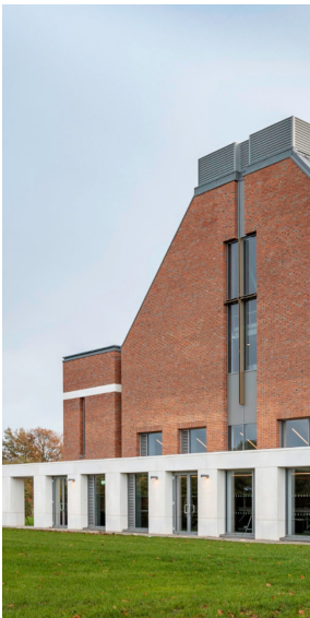
Fig.1 Vista frontale dell'edificio
