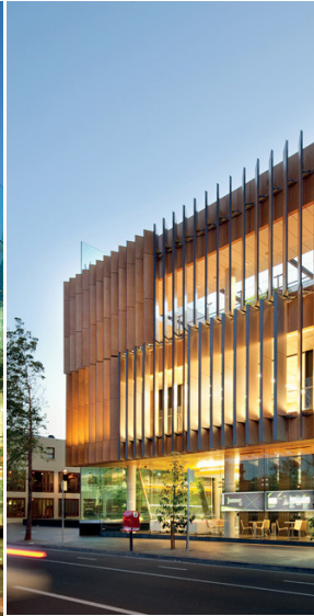
Fig.2 Vista della facciata d'ingresso all'edificio
