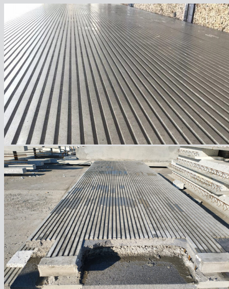
Fig.3 Applicazione della matrice su getto in calcestruzzo fresco.
