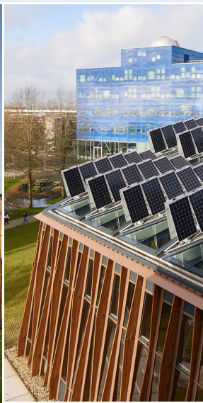
Fig.2 Vista esterna della facciata nord dell'edificio.
