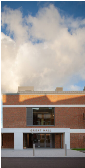
Fig.2 Vista frontale della facciata dell'edificio
