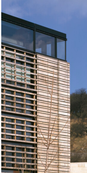
Fig.2 Vista della facciata esterna dell'edificio
