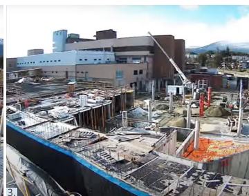
Fig.9 Fasi costruttive del TLVS, sequenza delle diverse fasi di realizzazione del labirinto. Dalle fondamenta alle prime strutture portanti, fino alla definizione degli elementi architettonici.
