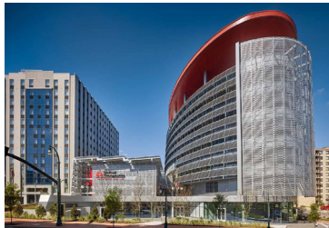
Figura 4.22 Vista esterna dell'edificio Unisphere. Fonte: EwingCole + Atelier Ten, Unisphere, Silver Spring, Maryland, USA.
