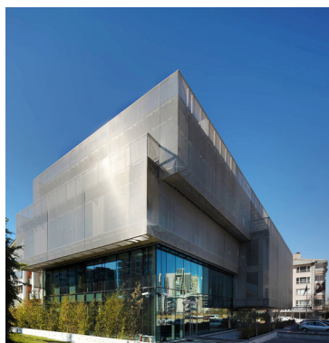
Figura 4.15 Vista esterna dell'edificio caratterizzato da un volume compatto rivestito da un involucro metallico microforato che funge da seconda pelle climatica. Fonte: ArchDaily, Turkish Contractors Association HQ / Avci Architects.
