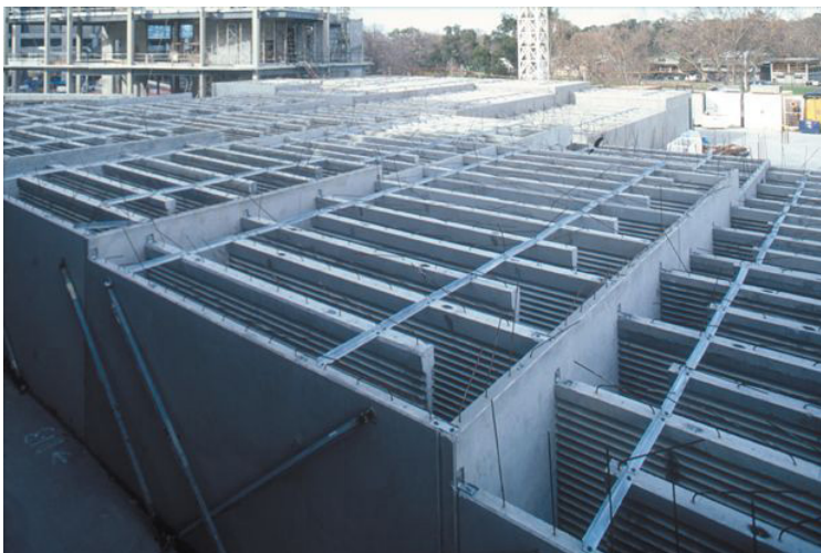
Figura 4.29 Sistema di labirinto termico in calcestruzzo (Thermal Labyrinth) in fase di realizzazione, costituito da setti paralleli ad alta massa termica che aumentano la superficie di scambio tra aria e struttura. Fonte: OCN – Online Construction Network.
