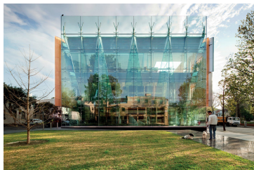
Figura 4.32 Vista della facciata nord dell'edificio. Fonte: Inhabitat, Surry Hills Library: Australia's new standard of sustainable excellence.
