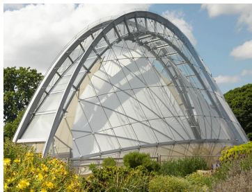
Figura 4.30 Alpine House, Royal Botanic Gardens, Kew (UK). Serra bioclimatica caratterizzata da involucro leggero e sistema di ventilazione naturale assistita, progettata per il controllo microclimatico interno con ridotto impiego di energia meccanica.
