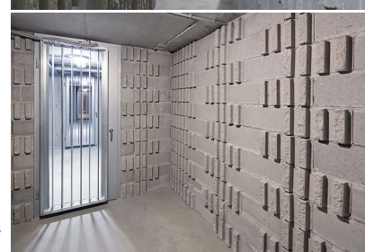
Fig.7 Pareti interne del TLVS nel piano seminterrato
