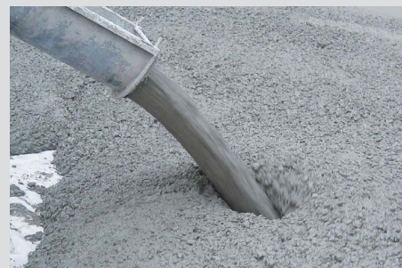
Fig.2_Getto di calcestruzzo fluido additivato con superfluidificante di nuova generazione
