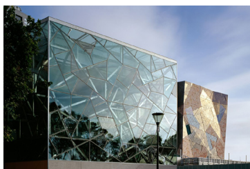
Figura 4.26 Vista esterna di uno dei volumi del complesso Federation Square. Fonte: LAB Architecture Studio + Bates Smart, Federation Square, Melbourne, Australia.
