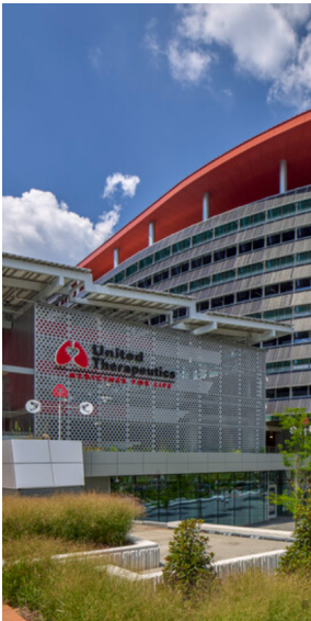
Fig.1 Vista della facciata frontale dell'edificio
