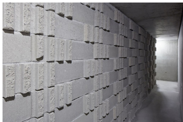
Figura 3.7 TLVS del sede centrale TMB ad Ankara. Fonte: -
