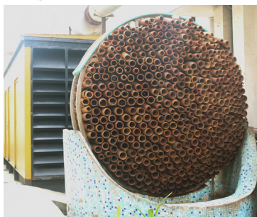
Figura 2.20 Schema concettuale del sistema di raffrescamento evaporativo in facciata (a); Installazione del sistema evaporativo in terracotta presso l'edificio DEKI Electronics, Nuova Delhi (b); Dettaglio costruttivo degli elementi ceramici del sistema di raffrescamento evaporativo (c); Funzionamento del sistema evaporativo mediante bagnatura degli elementi ceramici (d). Fonte: https://www.bu-ildnews.it/articolo/raffreddamento-evaporativo-in-facciata
