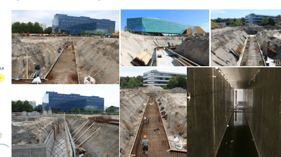
Fig.12 Viste della costruzione del TLVS
