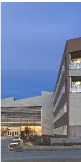
Fig.1 Vista frontale dell'edificio
