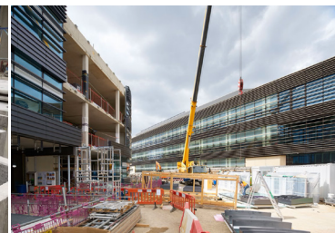
Fig.11 Realizzazione e installazione della facciata prefabbricata
