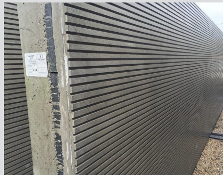
Fig.4 Superficie in calcestruzzo disarmato con finitura grecata verticale.
