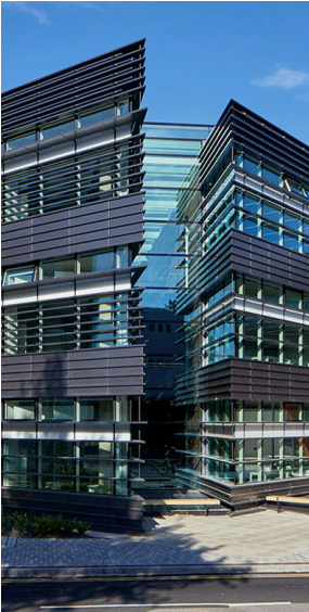
Fig.2 Vista della facciata frontale dell'edificio
