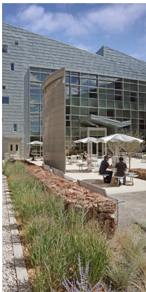
Fig.2 Vista frontale della facciata dell'edificio
