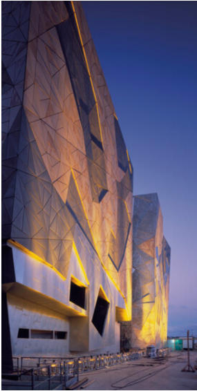
Fig.3 Dettaglio della facciata esterna dell'edificio
