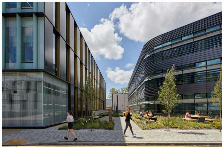
Figura 4.18 Vista dell'atrio interno del Big Data Institute (BDI) dell'Università di Oxford. Fonte: Make Architects, Big Data Institute, University of Oxford, Oxford, UK.
