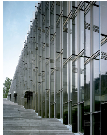
Figura 4.5 Dettaglio della facciata dell'Ewha Womans University Campus Complex. Fonte: Dominique Perreault Architecture, Ewha Womans University Campus Complex, Seoul.
