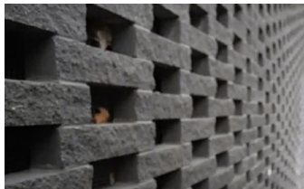
Fig.6 Facciata esterna del sistema di filtrazione dell'aria del labirinto termico
