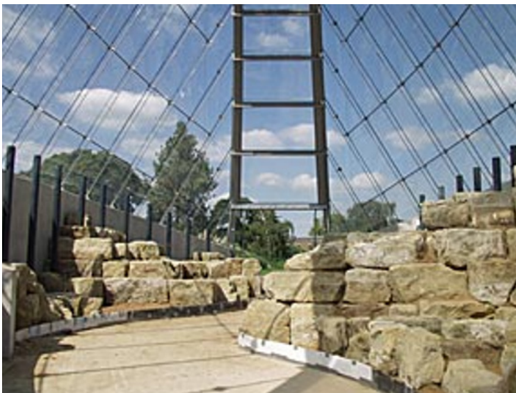
Figura 4.31 Percorso in muratura lapidea ad elevata massa termica, integrato nel sistema di ventilazione naturale per il raffreddamento passivo dell'aria attraverso scambio termico con superfici minerali. Fonte: Architettura e ventilazione passiva – immagini di progetto (web). Fonte: Royal Botanic Gardens, Kew.
