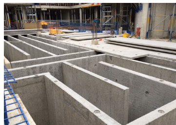
Fig.10 Realizzazione delle pareti interne del TLVS nel piano seminterrato
