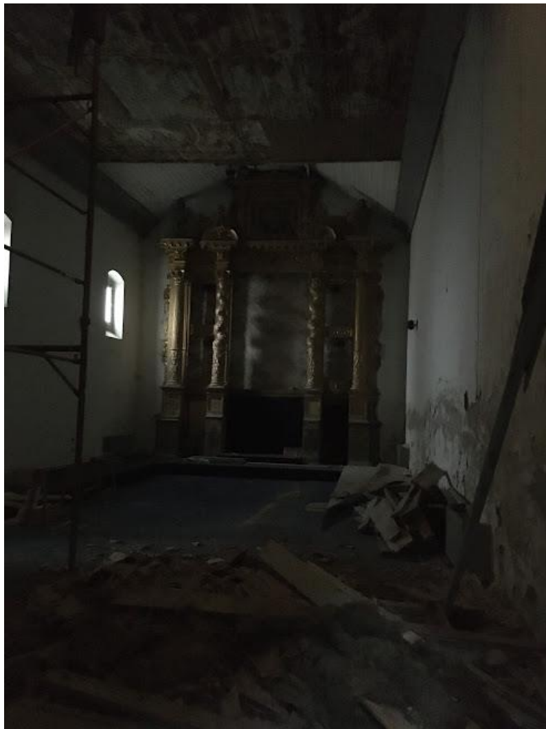
- Figg. 86-87. Teramo, chiesa di San Giuseppe, esterno e interno (stato attuale)
