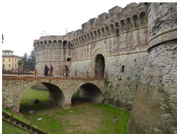
Fig. 4 – Colle di Val d'Elsa, veduta esterna della porta Volterrana dopo i lavori di restauro che nel 2005 hanno portato alla "riscoperta" del fossato e del ponticello di accesso alla città alta (foto Marina Docci 2011).
