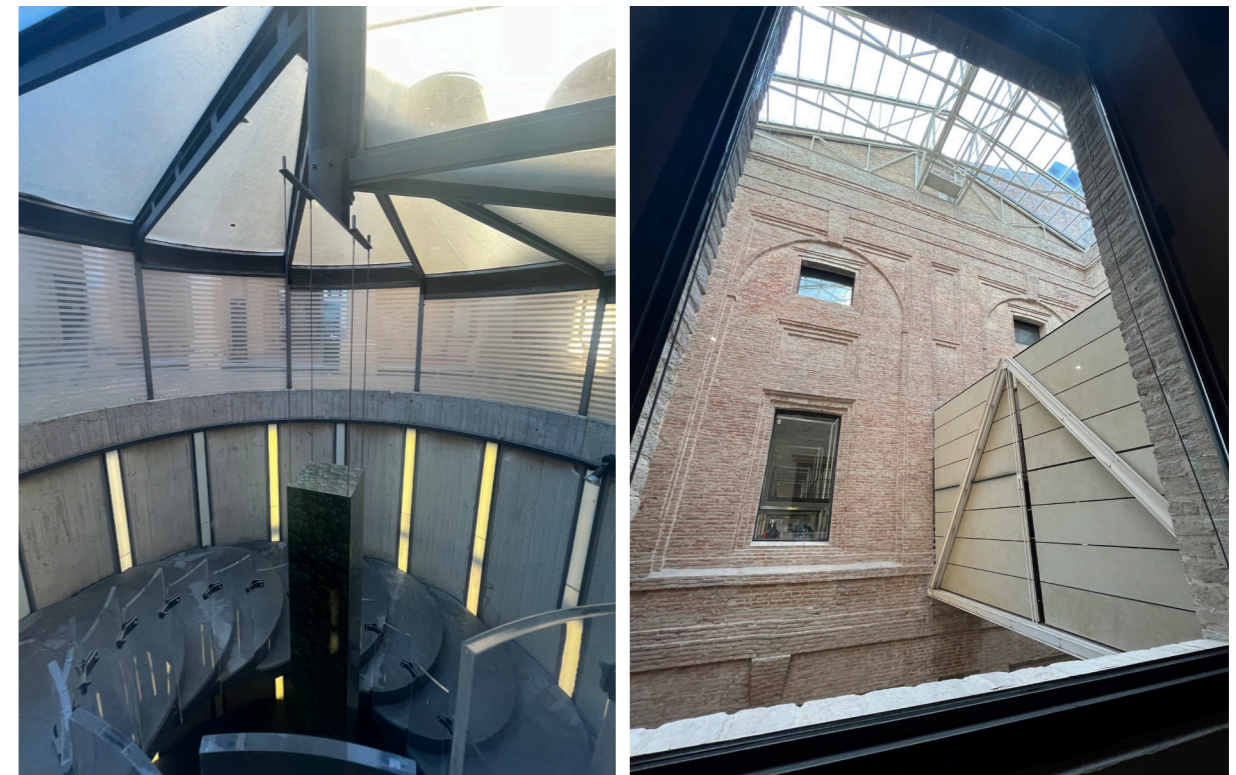
Figg. 3, 4 - A sinistra, Palazzo della Penna, Perugia; a destra, Palazzo della Pilotta, Parma.
