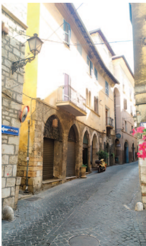
14. Alatri, via S. Francesco. Nonostante le facciate siano state intonacate e talvolta trasformate con nuove configurazioni architettoniche, possono osservarsi i caratteri architettonici riferibili al XIII secolo: i portali ogivali alla quota stradale e le bifore al primo piano
