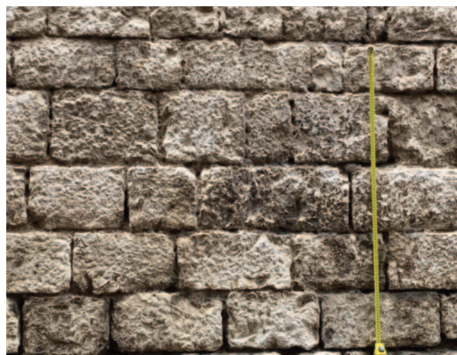
13. Alatri, unità edilizia posta in angolo tra via Ceci e corso Vittorio Emanuele. Particolare del tipo murario riferibile all'inizio del XIV secolo
