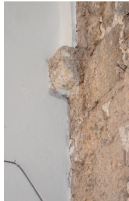
34c. Alatri, palazzo Conti Gentili. Particolare della mensola di imposta delle volte appena sporgente dal muro
