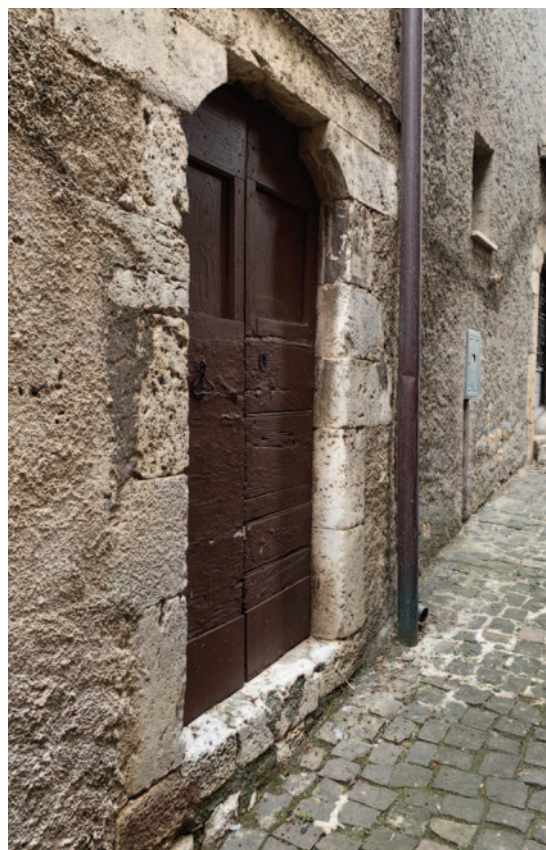
35. Alatri, unità edilizia in via dei Vineri. Particolare dell'apertura architravata
