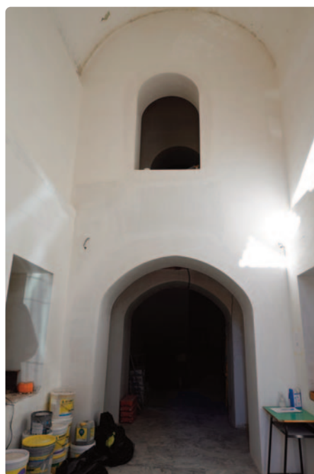
39. Alatri, palazzo comunale. Particolare dei vani di finestra presenti all'interno dell'androne. Tali aperture appaiono riferibili alle unità edilizie preesistenti, oggetto di rifusione per la costruzione del palazzo
