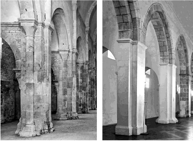
Fig. 17a-b. Pilastrate delle navate centrali di Fontenay (Viaggiolibera, da Google) e di Bonmont (Torpille, da Google)
