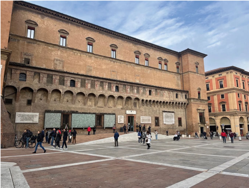
Fig. 1 Bologna, Sala della Borsa entrance ( Source Marichela Sepe' archive)
