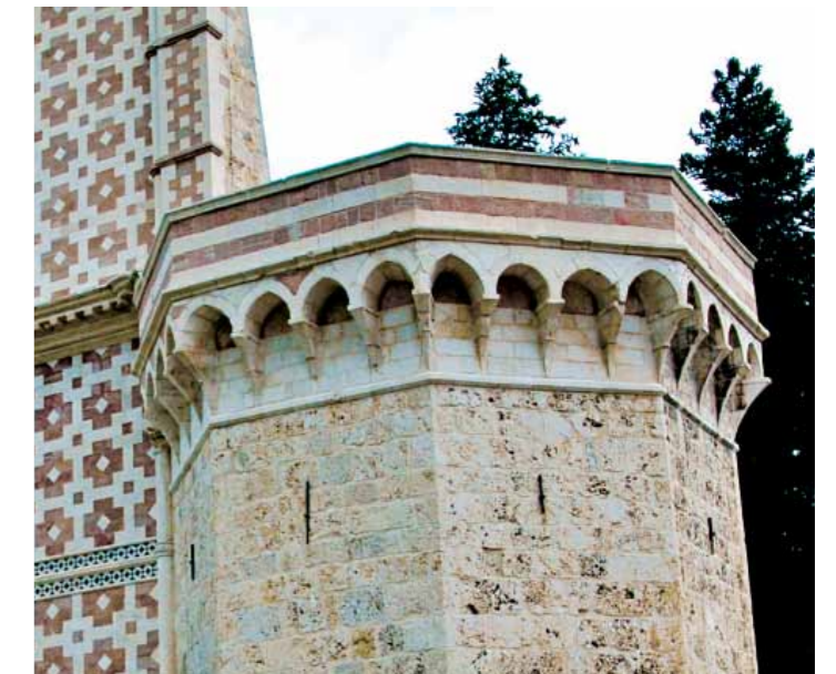
Fig. 3 - Parte superiore della torre di facciata realizzata con calcare compatto e pietre rosse.
