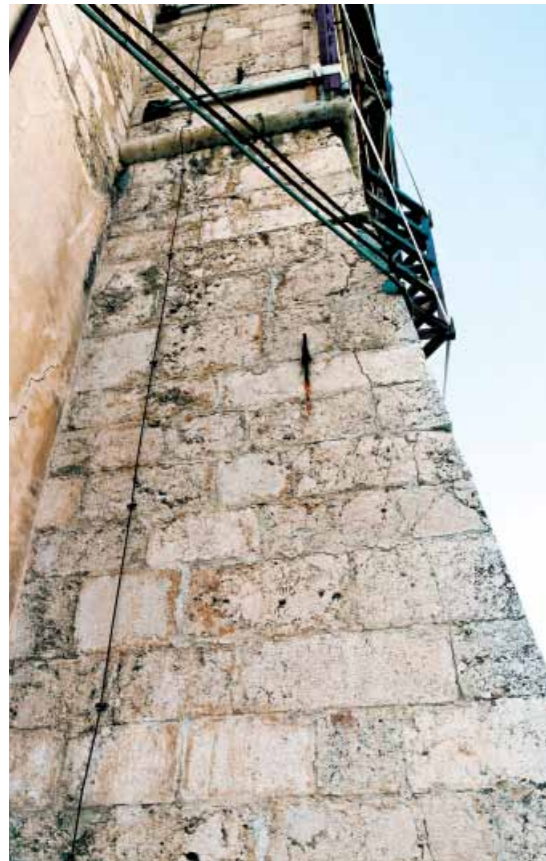
Fig. 1 - Sperone di rinforzo dell'abside centrale.
