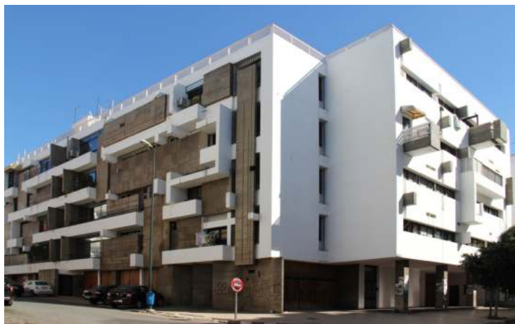
J.-F. Zévaco, Immeuble de la Société Civile du Centre, Rabat, 1949
