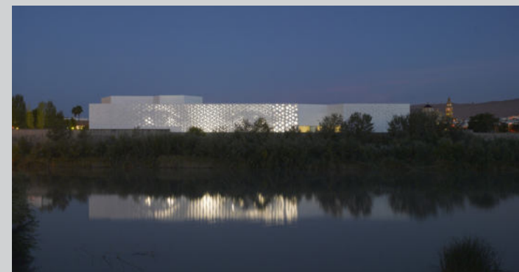
Immagini esterne della facciata e del tetto del Centro per la Creazione Contemporanea dell'Andalusia / Exterior images of the façade and roof of the Centre for Contemporary Creation of Andalusia
