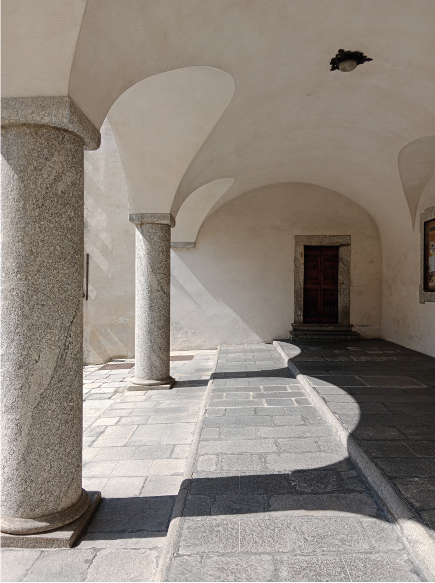
Figura 9. L'intervento di Luigi Caccia Dominioni per la copertura degli ingressi laterali alla chiesa. Le nuove colonne sono realizzate con la pietra di Moltrasio, tipica del luogo. Foto M. Zammerini.
