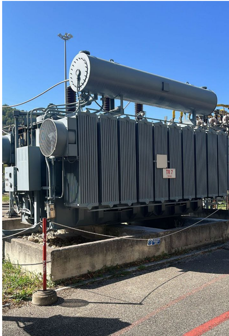
Figura 9.2: Il trasformatore trifase in esame da 80MVA
