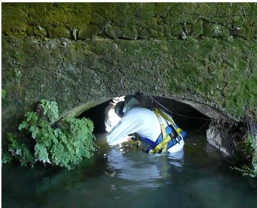
Fig. 46. Un momento dell'ispezione: il passaggio dalla botte est alla botte ovest.
