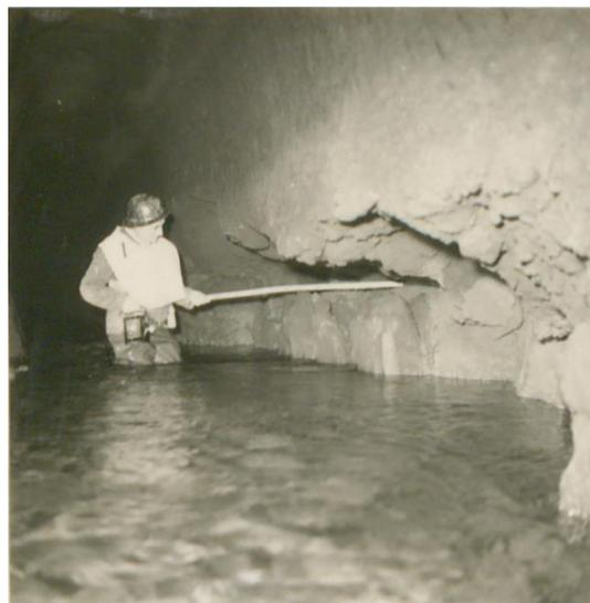
Fig. 69. *Aqua Virgo* tra Salone e La Rustica: frane della volta e dei piedritti hanno spesso ostruito il condotto e modificato la sezione dello speco. Da ASA, foto 6004 e 6000.
