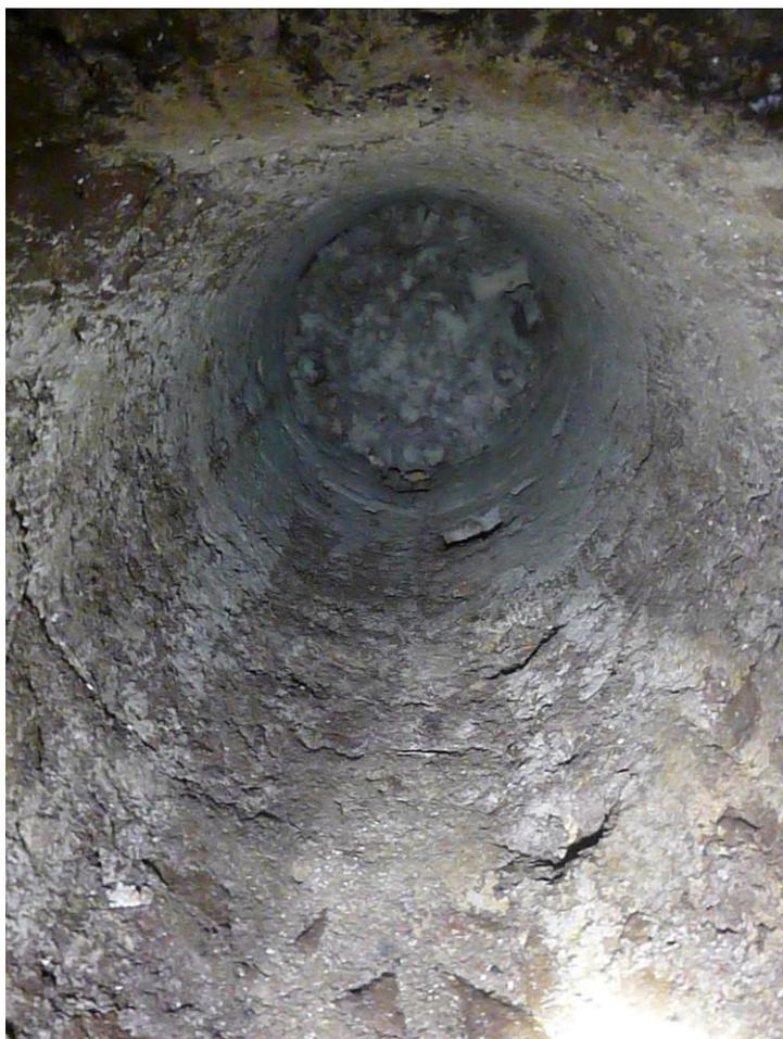
Fig. 117. Pozzetto a pianta circolare. In evidenza le pedarole.
