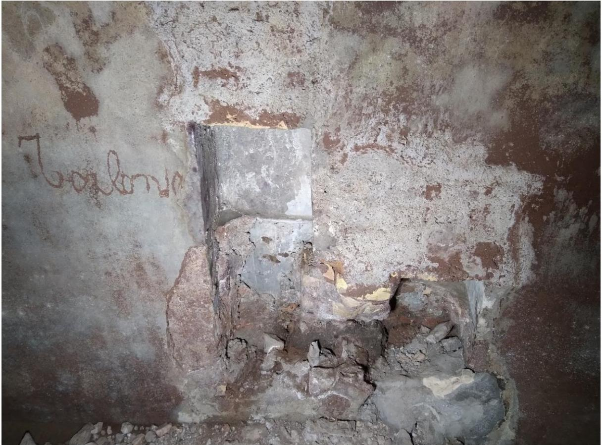
Fig. 133. Cassetta idrometrica destinata alla famiglia dei Torlonia individuata al di sotto del palazzo della Rinascite lungo la parete destra dello speco. La cassetta è stata divelta, tuttavia nella parte inferiore restano visibili i tubi.
