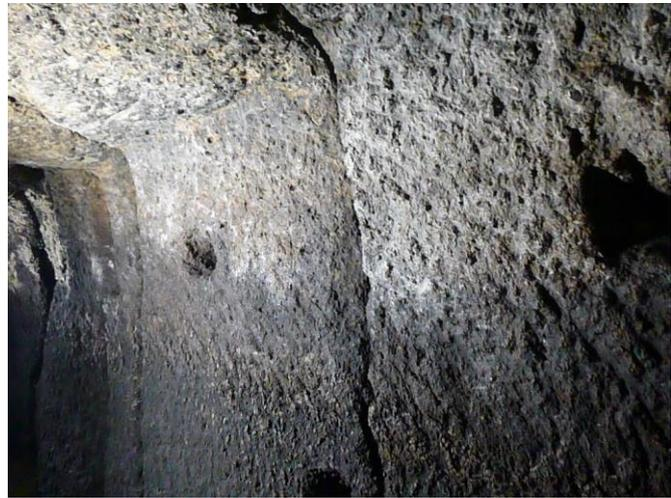
Fig. 53. Salone, *Aqua Virgo*. Ampia scanalatura verticale ricavata nella parete destra dello speco.
