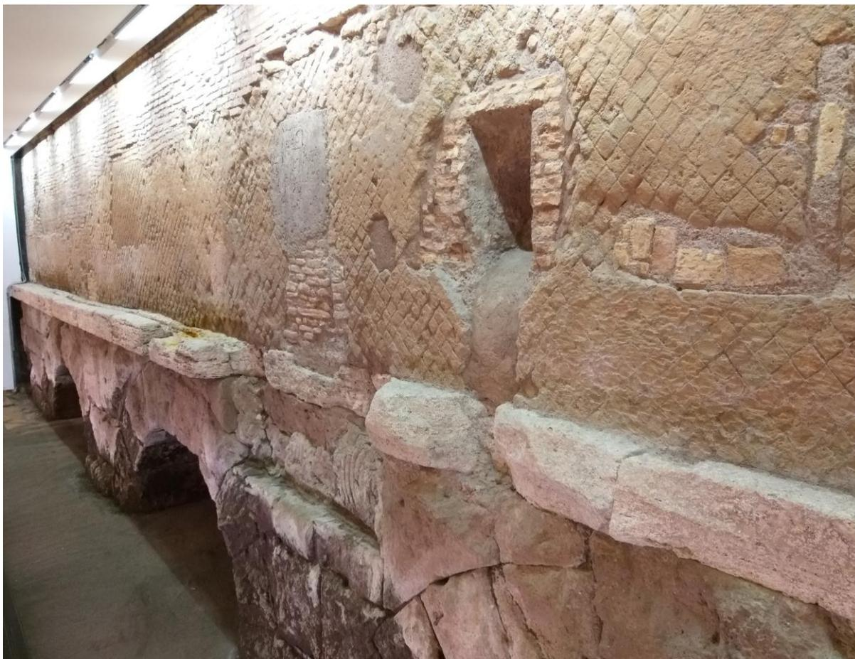
Fig. 127. La Rinascente, tratto su di arcuazioni (lato sud est). Primo piano degli archi 10, 9 e 8 con in evidenza il marcapiano in travertino su cui poggia lo speco con cortina muraria molto disomogenea.
