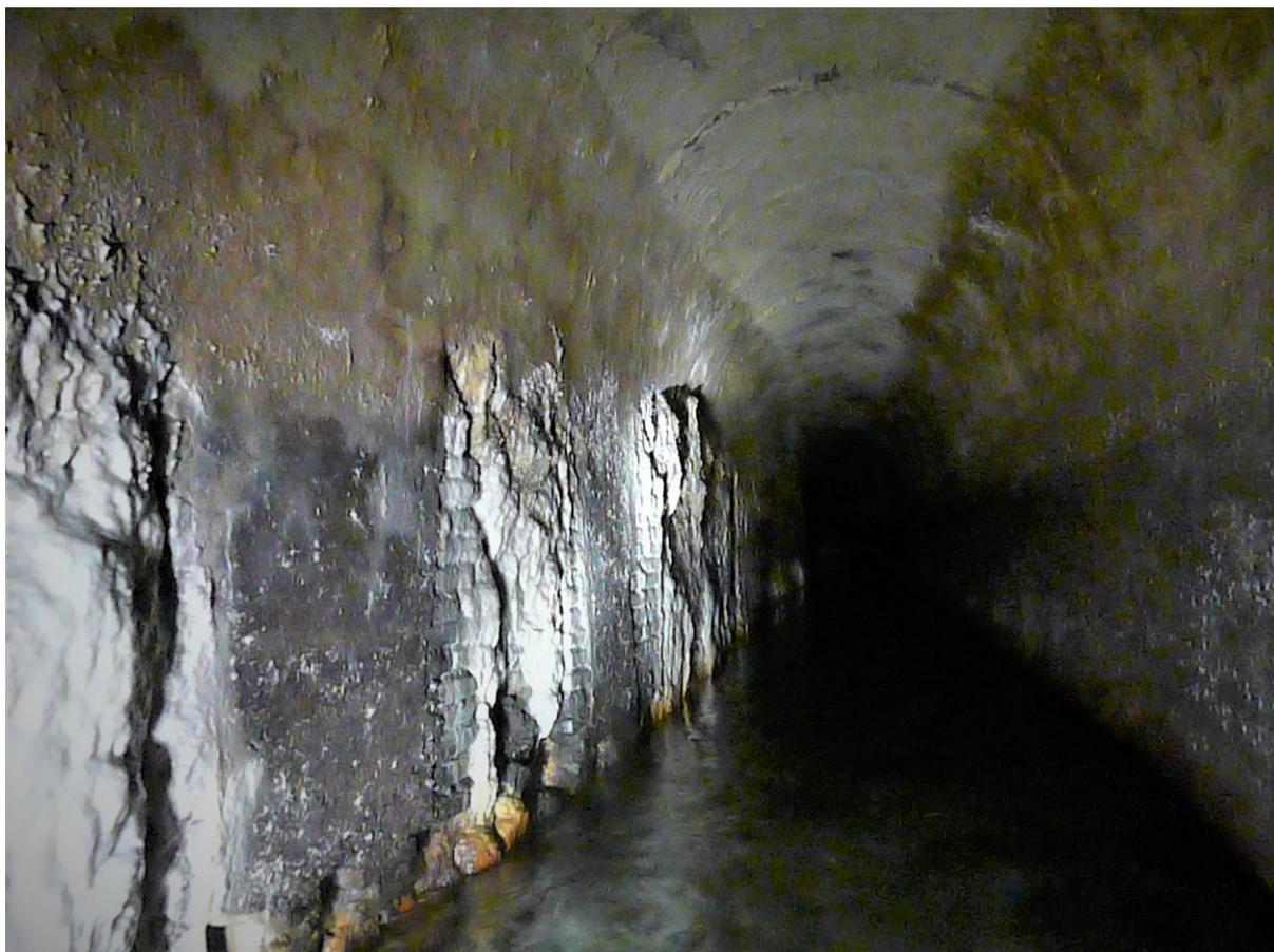
Fig. 119. *Aqua Virgo*, Speco visto da monte. A sinistra i paramenti laterizi ricoperti dall'intonaco e intervallati da blocchi di roccia. In basso le bocchette di presa.
