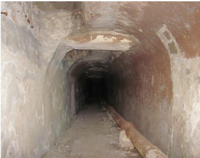
Fig. 132. *Aqua Virgo* visto da monte in direzione di Via del Nazareno. Si notino la catena in travertino e a destra, murata, una cassetta per la distribuzione dell'acqua.
