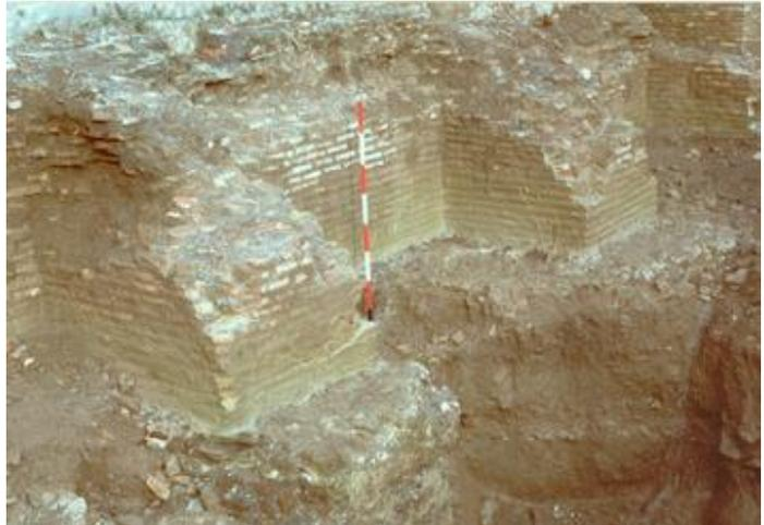
Fig. 100. Struttura di consolidamento in opera laterizia tra i contrafforti nove e dieci (lato sud) e datata al IV-V secolo d.C. Da SITAR, foto 43010, codice OI 4098, PA 17779.
