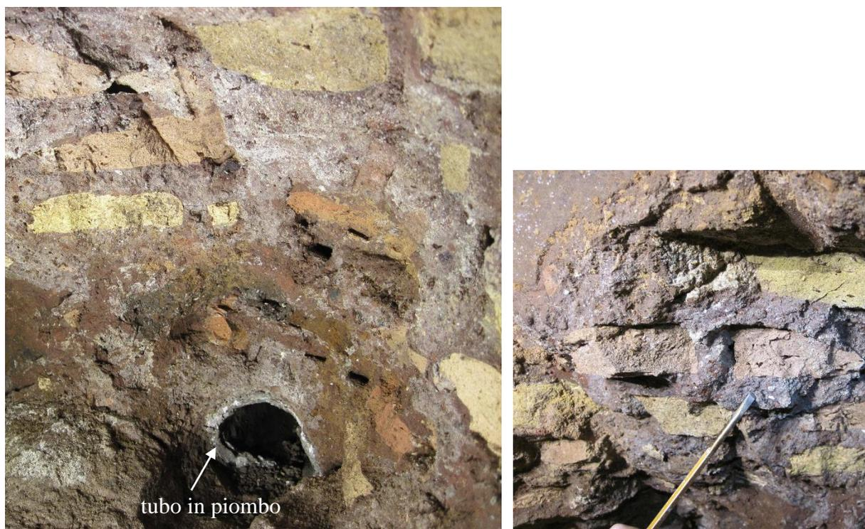
Fig. 268. Parte inferiore della parete dx dello speco con indicazione del tubo in piombo. A dx, dettaglio del punto di prelievo del campione.
