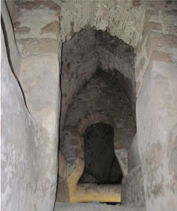
Fig. 131. Primo piano del passetto tardo-medioevale con copertura a ogiva visto dallo speco in direzione di Via del Nazareno.
