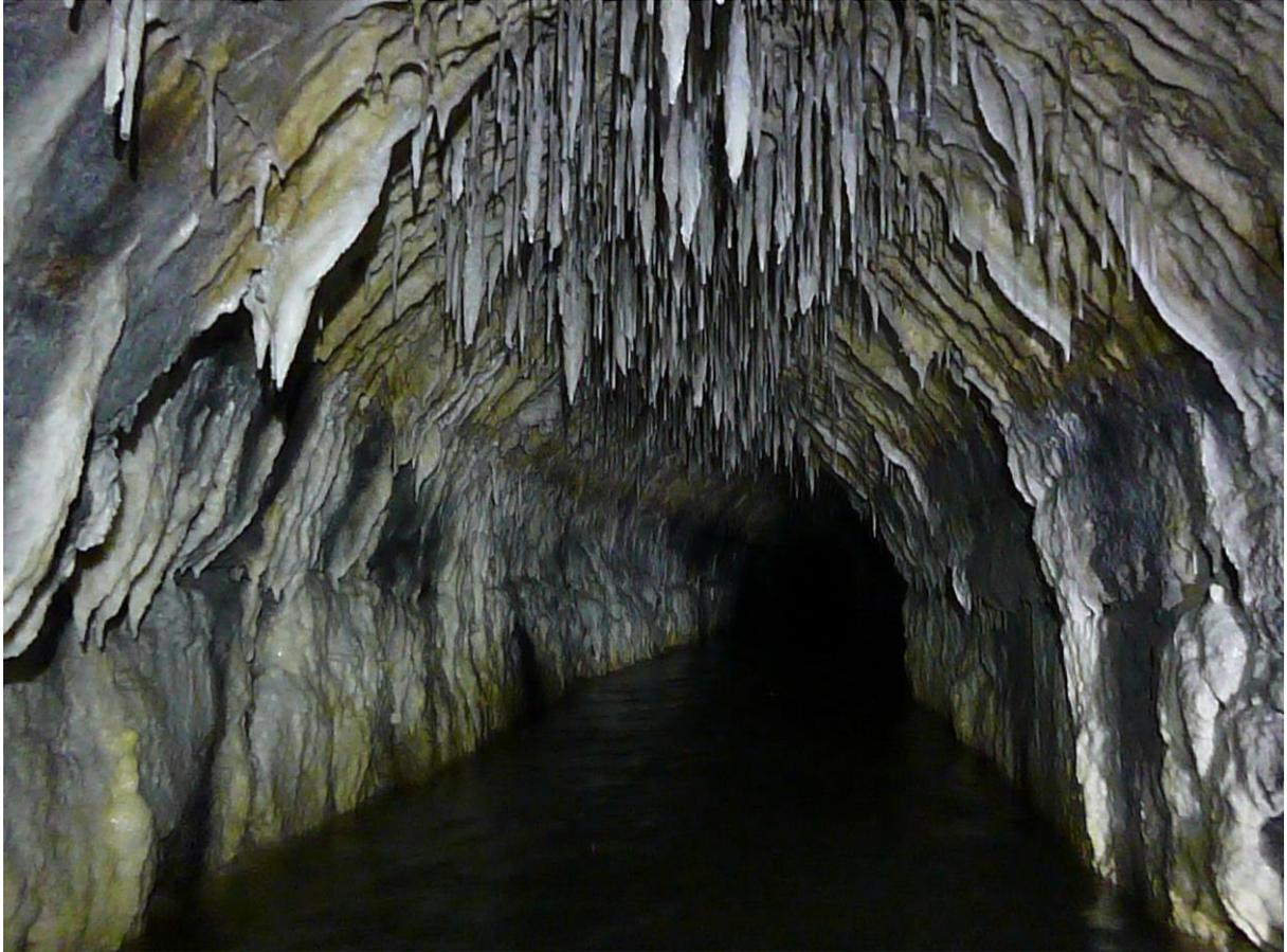
Fig. 123. *Aqua Virgo*. Abbondanti percolazioni dai piedritti e dalla volta. Foto da valle verso monte, tra il pozzo a pianta rettangolare e quello successivo a pianta circolare.
