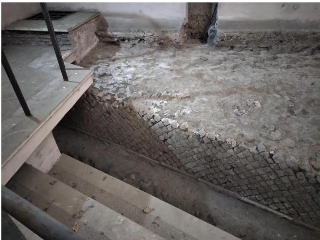
Fig. 107. Il tratto di acquedotto rivestito in *opus reticulatum* visibile in uno dei locali ipogei del Museo. A sinistra il pozzetto di aerazione a pianta quadrata che comunica con lo speco.
