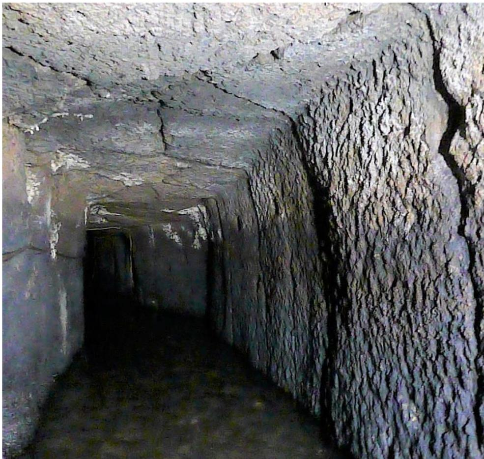
Fig. 51. Salone, condotto principale scavato nel banco tufaceo. Cornici lasciate sulle pareti e sulla volta.
