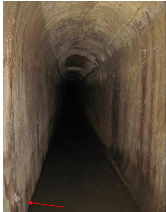
Fig. 129. *Aqua Virgo*. I piedritti presentano un rivestimento più uniforme e nella volta sono ben riconoscibili le tracce lasciate dalle palanche. In basso nella parete di sinistra e indicata dalla freccia è presente una fistola in bronzo.
