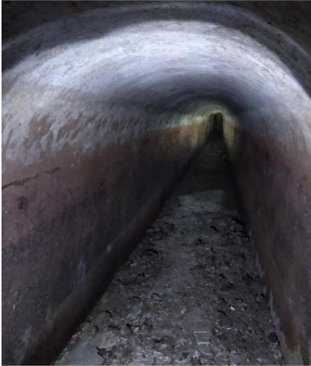
Fig. 128. Lo speco nel tratto più a monte con rivestimento di colore rosso scuro sui piedritti e bianco sulla volta. Sul fondo accumuli di detriti di vario genere.
