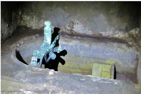
Fig. 134. Dettaglio della vaschetta superiore (a valle) in una cassetta idrometrica ben conservata sul lato destro dello speco. All'interno della vaschetta sono ancora visibili le indicazioni del livello dell'acqua.
