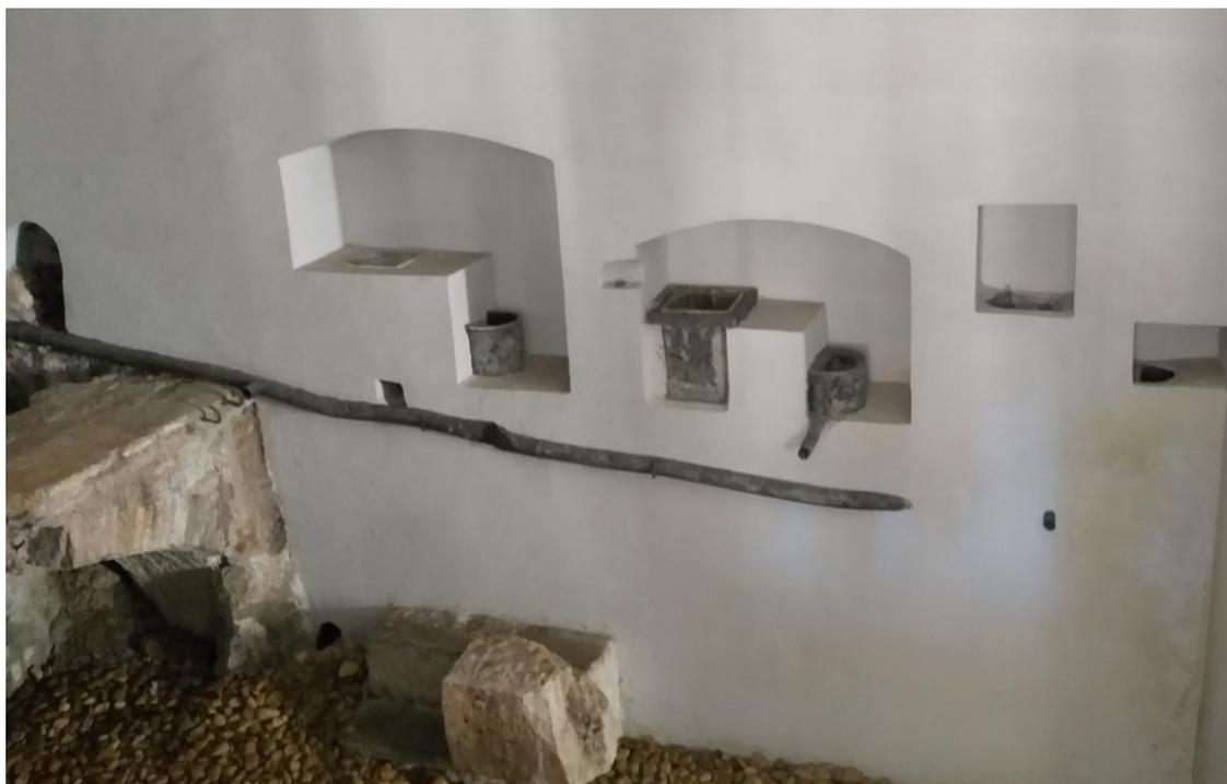
Fig. 140. Castello di Trevi. Cassette idrometriche e tubature per la distribuzione dell'Acqua Vergine ai vari utenti.
