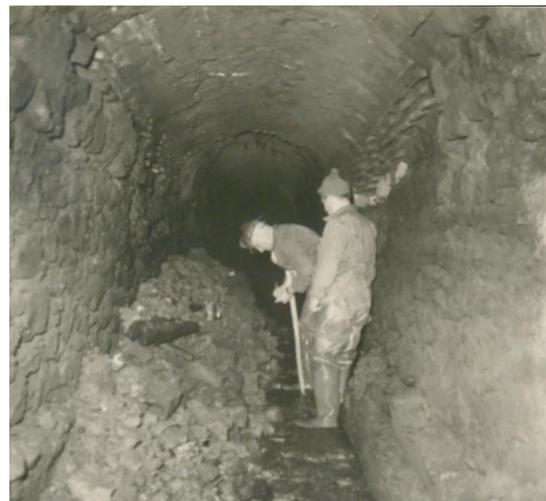
Fig. 70. Momenti dell'ispezione al condotto in località La Rustica con grandi accumuli di detriti all'interno dello speco. Da ASA, foto 6064 e 6061.
