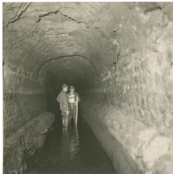
Fig. 67. A sinistra, lo speco nel tratto più a monte, direttamente scavato nel tufo.
