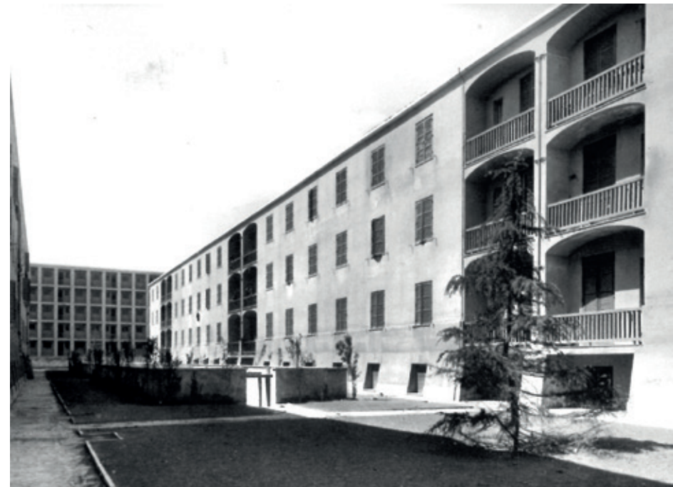
Fig. 3 - a) I prospetti "reticolati" degli edifici a ballatoio del lotto 2 visti da via Ascoli Satriano.
