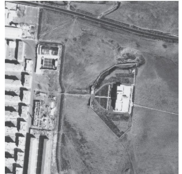
Fig. 3 - Aereofoto AM 1955, l'Istituto è ultimato nel suo corpo principale, evidente l'organizzazione dello spazio verde ad "orto di necessità" per venire incontro alle esigenze di refezione delle suore e dei molti ospiti del collegio. Si nota inoltre il segno del percorso che si attesta su via Trani e del "ponticello" sopra il fosso del Quarticciolo ancora a cielo aperto, © ICCD-AN, AM, 1955, f. 150, str. 2, fotogr. 1085.
