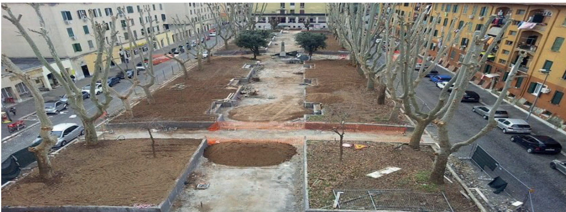
Fig. 1 - Piazza del Quarticciolo durante i lavori condotti nell'ambito del programma Contratto di Quartiere II-Quarticciolo, 2004.
