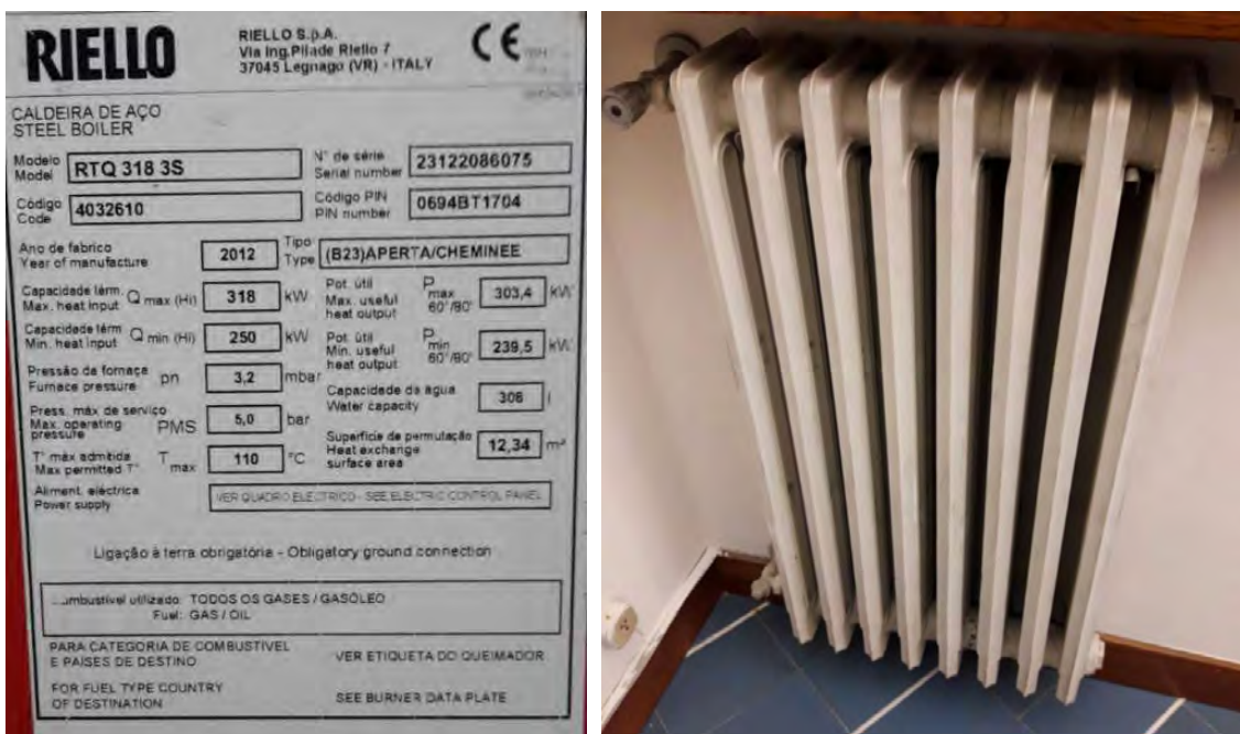
Fig. 5: Caratteristiche termiche Caldaia (sinistra) e esempio di radiatori presenti (destra)
