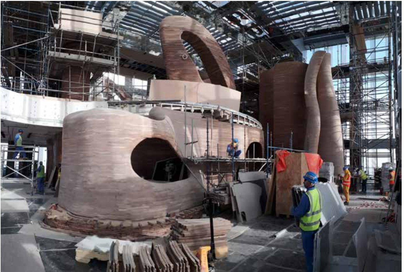
Fig. 12 Montaggio in cantiere dei tasselli lignei per la costruzione delle pareti (foto: Devoto Design).
