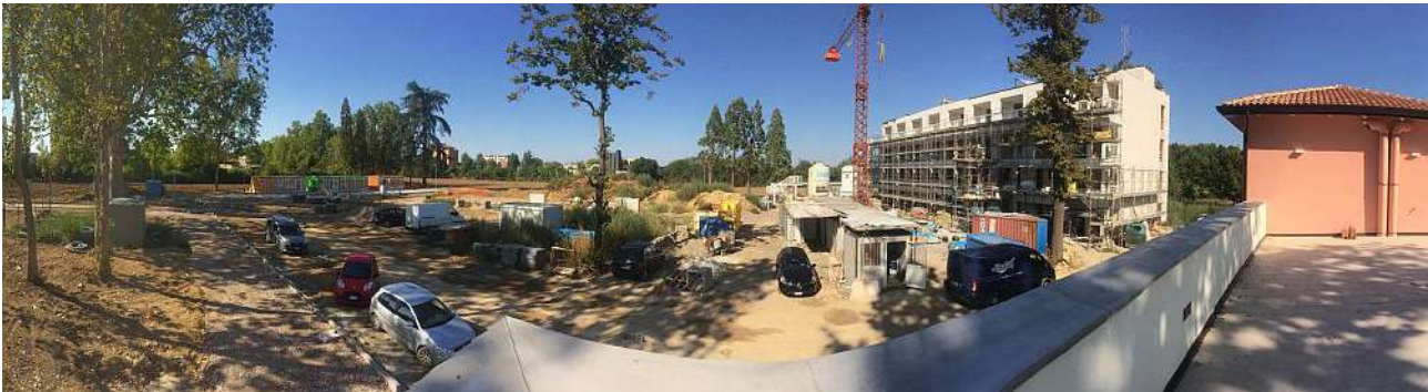
Fig. 4 Il cantiere di Salus Space. Foto: Salus Space.
