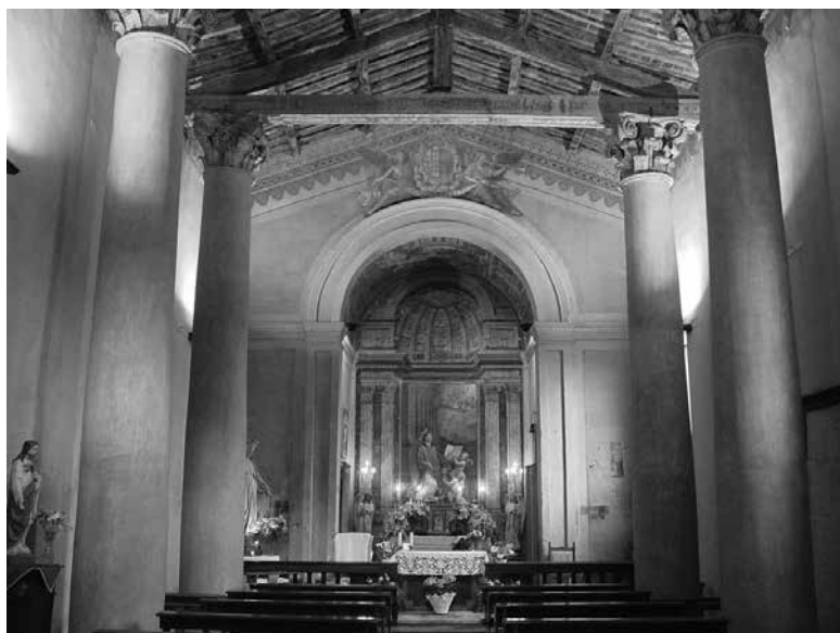
Fig. 10. Arsoli, chiesa di S. Lorenzo. Colonne lignee facenti parte dell'arco di trionfo da Camillo Massimo in onore di Pio VI (foto F. Censi, in < http://www.prolocodiarsoi.it/chiesa%20di%20san%20lorenzo.htm > ultimo accesso 26.03.2019).
