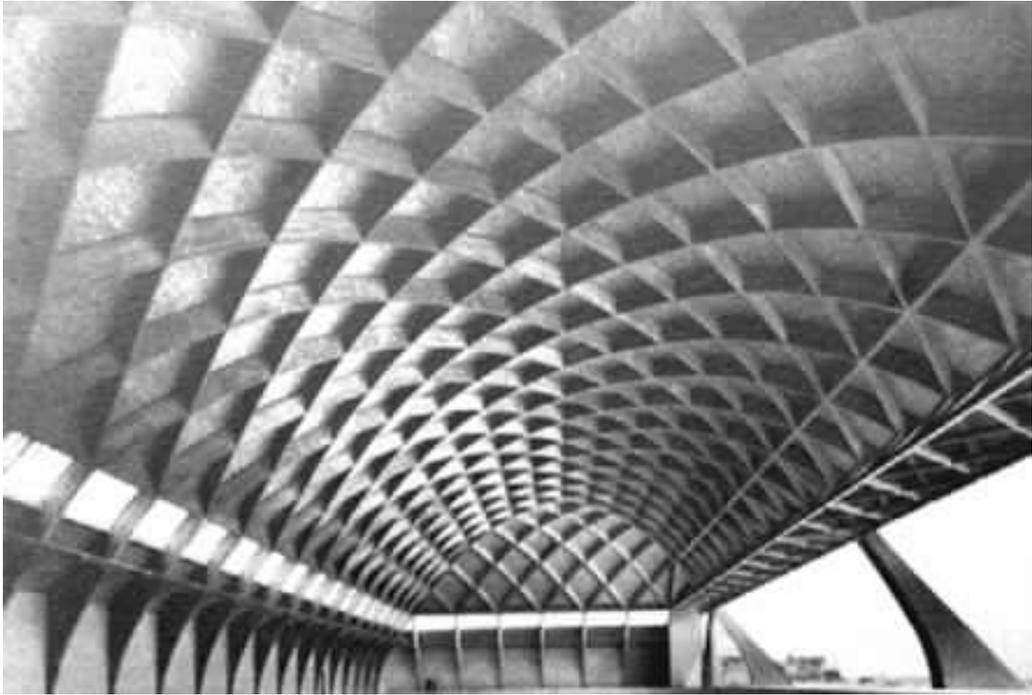
Figura 50. P. Nervi, Aviorimessa per l'Aeronautica di Orbetello, 1935. Le linee di forza della superficie ricavata da una curva parabolica sono marcatamente denunciate, trasformandosi in tema compositivo oltre che strutturale.
