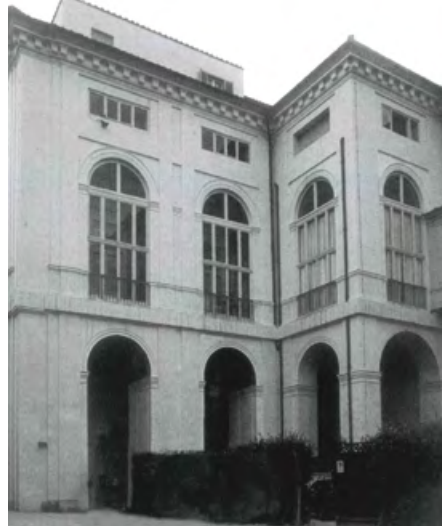
Da sinistra, figura 10. Roma, convento di Santa Sabina, cappella di San Domenico, vestibolo (foto A. Russo); figura 11. Roma, palazzo del Quirinale, loggia di Clemente IX in corrispondenza delle "Sale Rosse" (da ROBERTO 2004, fig. 8).
