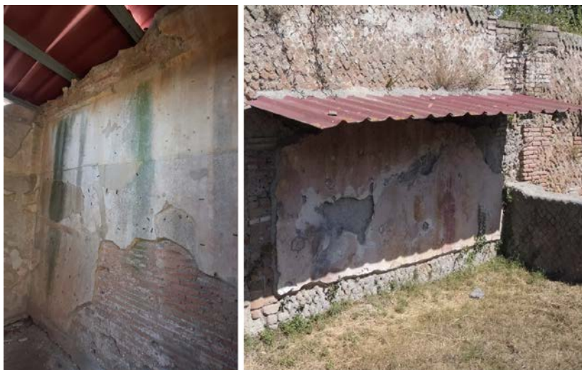
Fig. 2. Esempi di colonizzazione biologica legata alla percolazione delle acque meteoriche e di distacco dell'intonaco legato all'azione del vento (foto dell'autrice).
