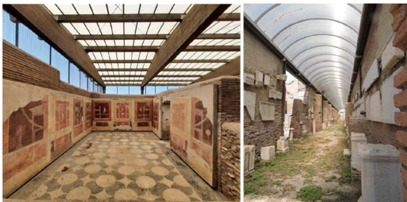
Fig. 4. Esempi di strutture di protezione che dialogano formalmente con la preesistenza (Insula della Ierodùle e area del Piccolo Mercato) (foto dell'autrice).
