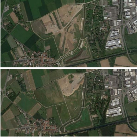
Figura 39. L'area di cantiere presso il comune di Nerviano (Milano), sopra al 2019 e sotto l'area ripristinata al 2020
