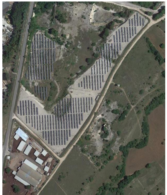
Figura 11. Installazione di impianti fotovoltaici a terra nel comune di Massa D'Albe (L'Aquila), immagine 2019 (in alto) e 2020 (in basso)
