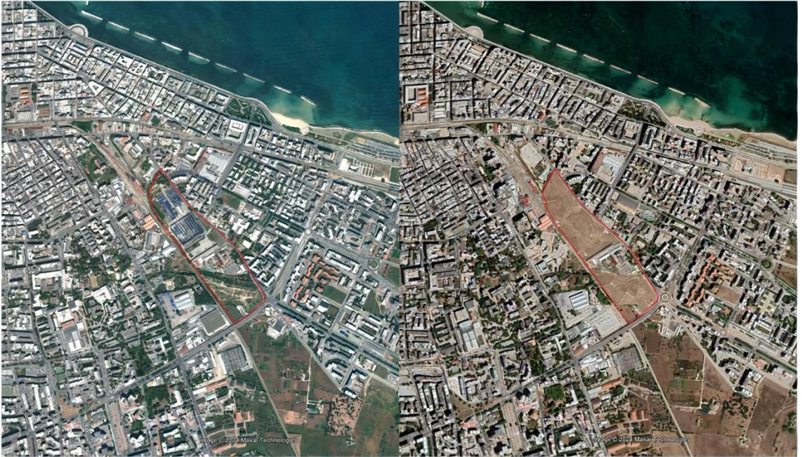
Figura 197. Area oggetto di bonifica e di riconversione dell'uso di suolo prima (sinistra) e dopo l'esecuzione dei lavori (destra)
