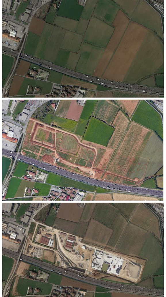
Figura 40. Lonato del Garda in provincia di Brescia, cantiere ferroviario per l'alta velocità (10 ettari)
