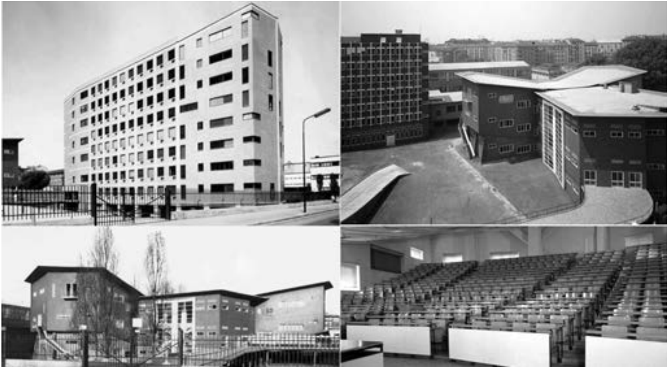
Fig. 2 - Edifici Nave, Torre e Trifoglio, vista esterna e dell'interno di una delle grandi aule a gradoni al momento dell'inaugurazione (Area Tecnico Edilizia del Politecnico di Milano).
