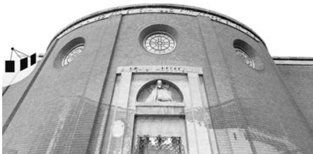
Fig. 3 - Il rilievo integrato: acquisizione massiva.
