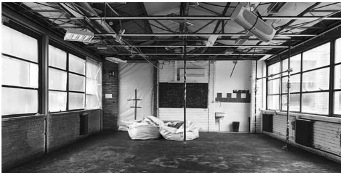
Fig. 2 - L'Istituto di Fisica, ambienti interni da restaurare.
