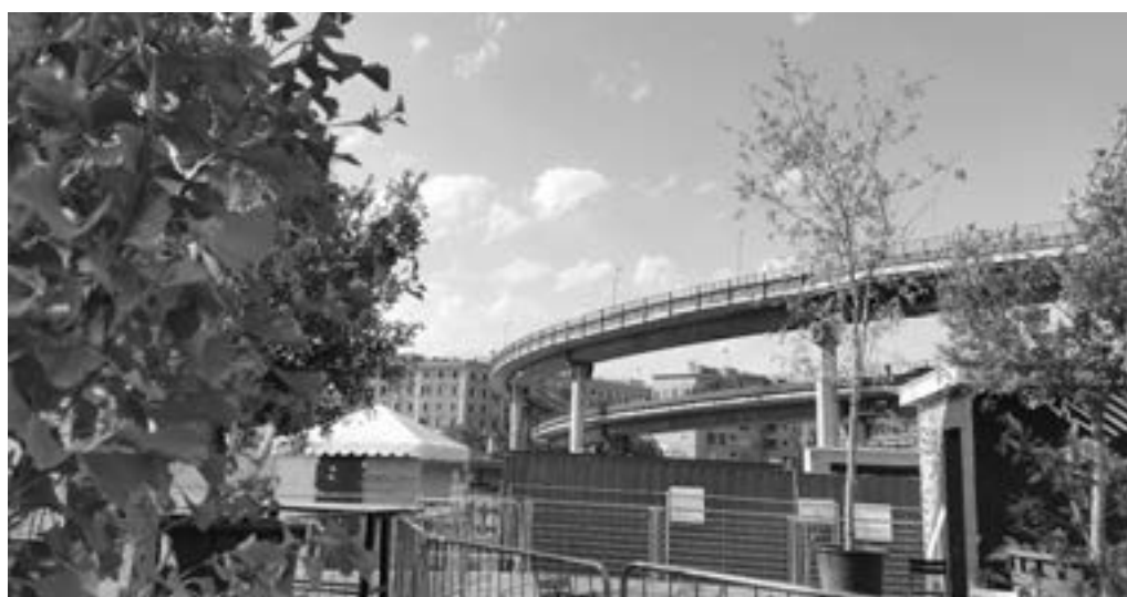
Fig. 6 - Il Bosco Temporaneo "in costruzione": 100 alberi per mitigare la durezza del paesaggio della ex-Dogana (foto dell'A.).
