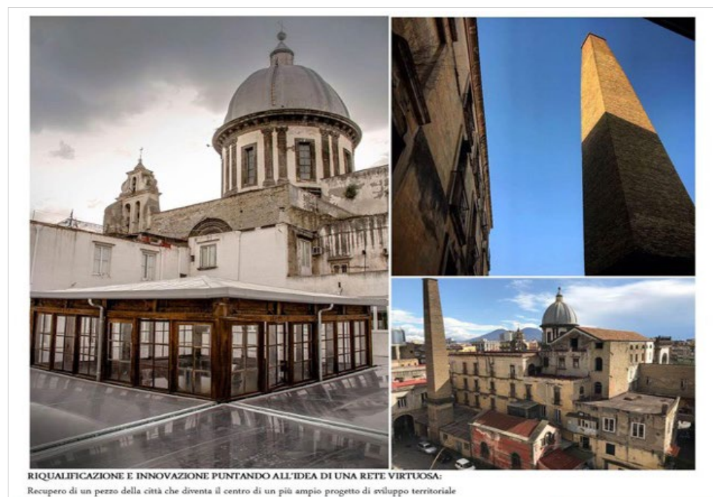
Fig. 1. Insula dell’ex Lanificio e recupero del Chiostro di Santa Caterina a Formiello (fonte: elaborazione Studio Keller).
