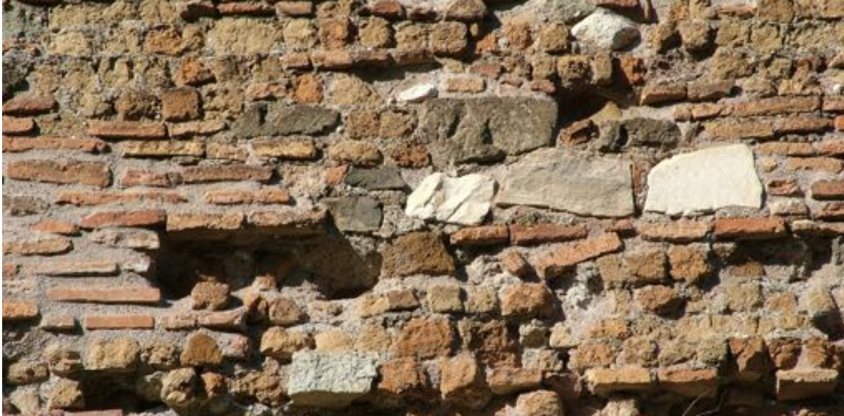
11 Roma, Mura Aureliane: restauro di Niccolò V, si osserva l'uso di cubilia di reimpiego.
