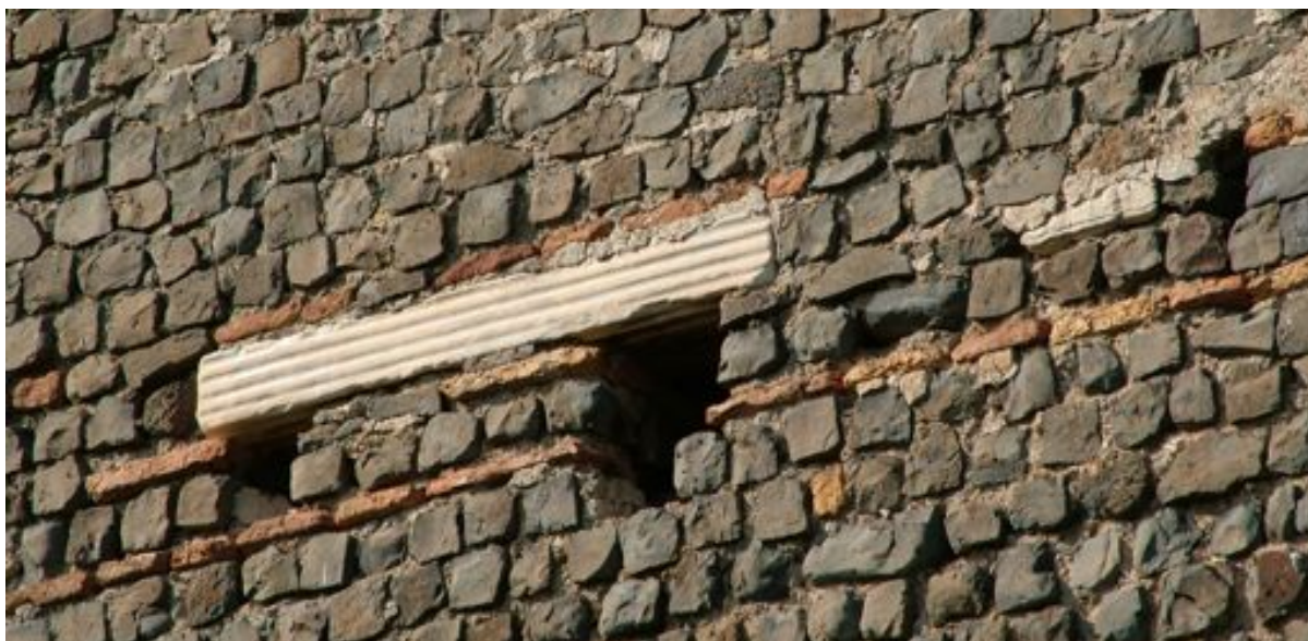
2 Roma, Torre Jacova: traversa di fori pontai in marmo e orizzontamento in laterizi di reimpiego (XIII secolo).
