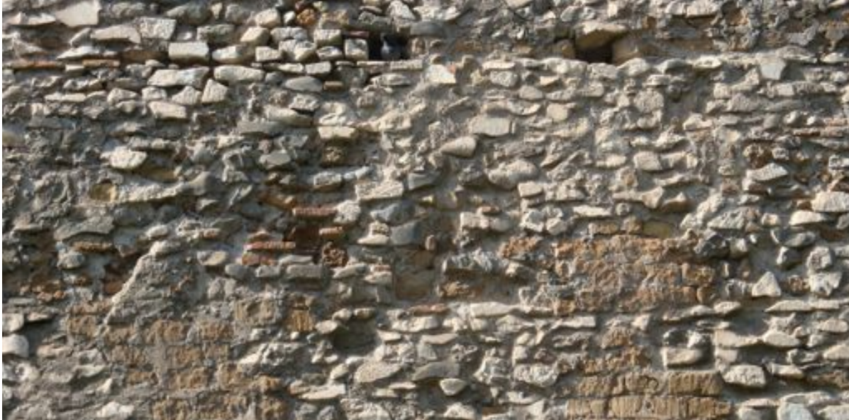
4 Roma, Mura Aureliane, cortina L34-35: particolare della muratura irregolare di vario materiale.
