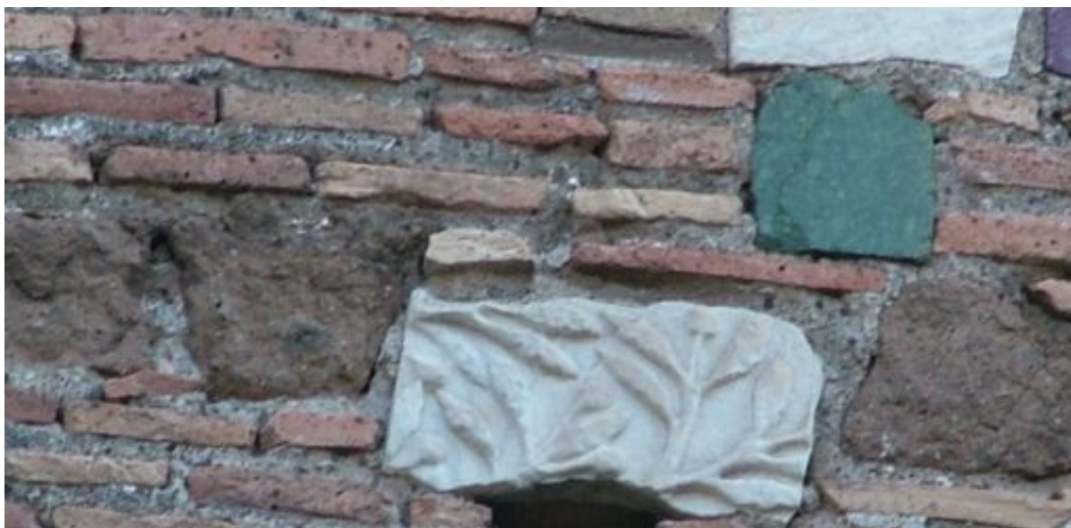
9 Roma, S. Agnese fuori le mura: particolare del foro di alloggiamento della traversa lignea del ponteggio (XII secolo).
