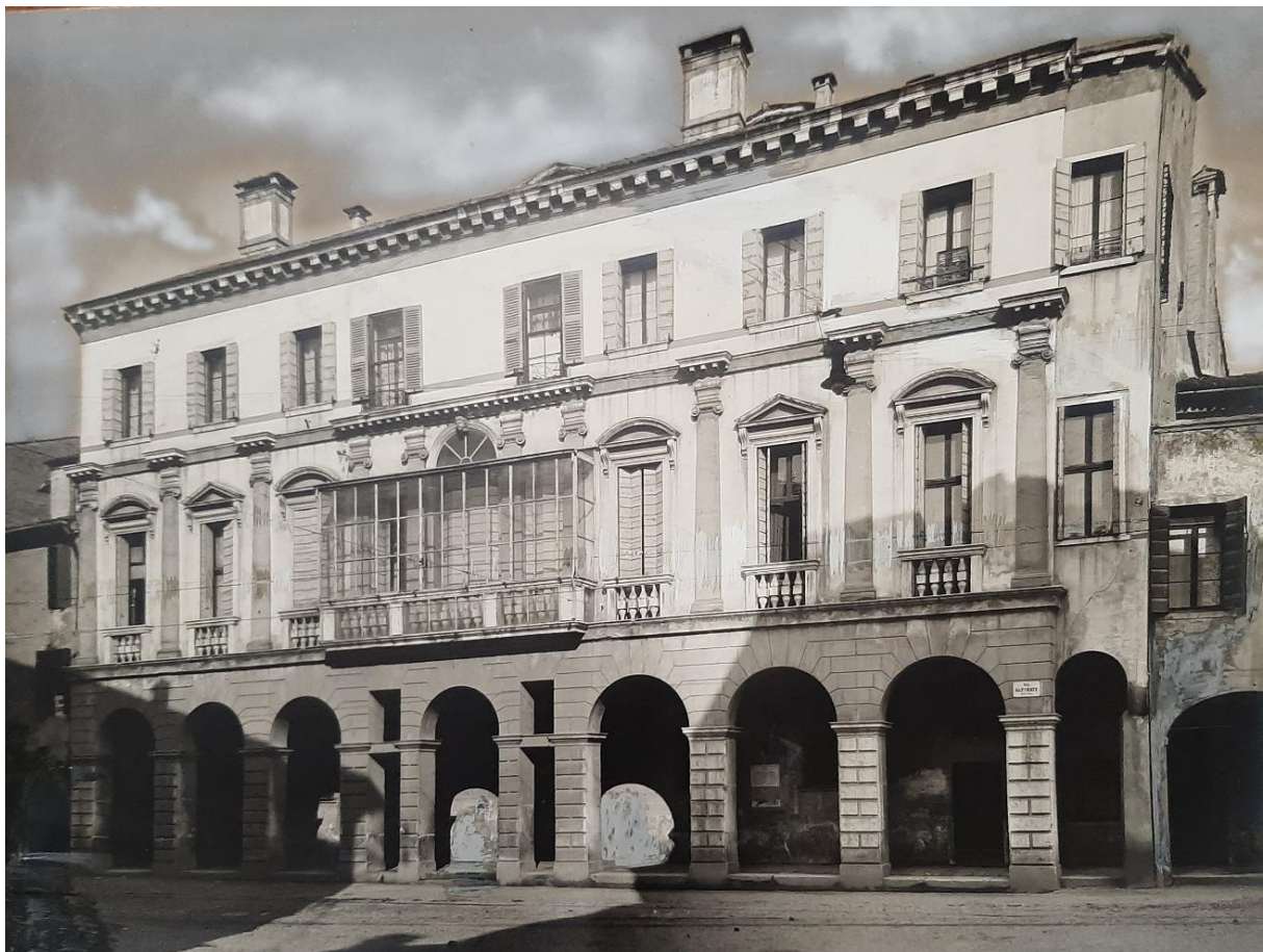
FIG. 77: Esempio di ritocchi (nuvole ad aerografo e ricostruzione pittorica di buona parte dell'edificio)
