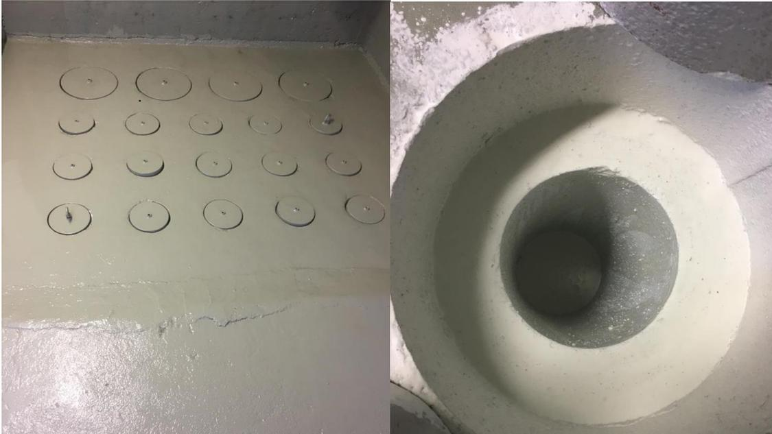
**Figura 6** – Pavimentazione a fine lavori e dettaglio di una delle buche.
