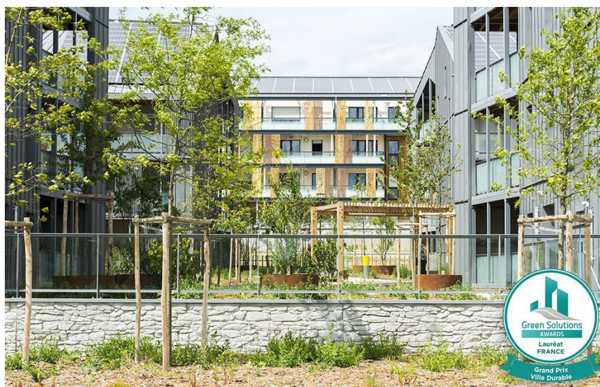
Fig. 1: Vista degli edifici i cui involucri sono studiati per massimizzare il comportamento bioclimatico passivo. Fonte: Loire-Atlantique Développement (2022)
