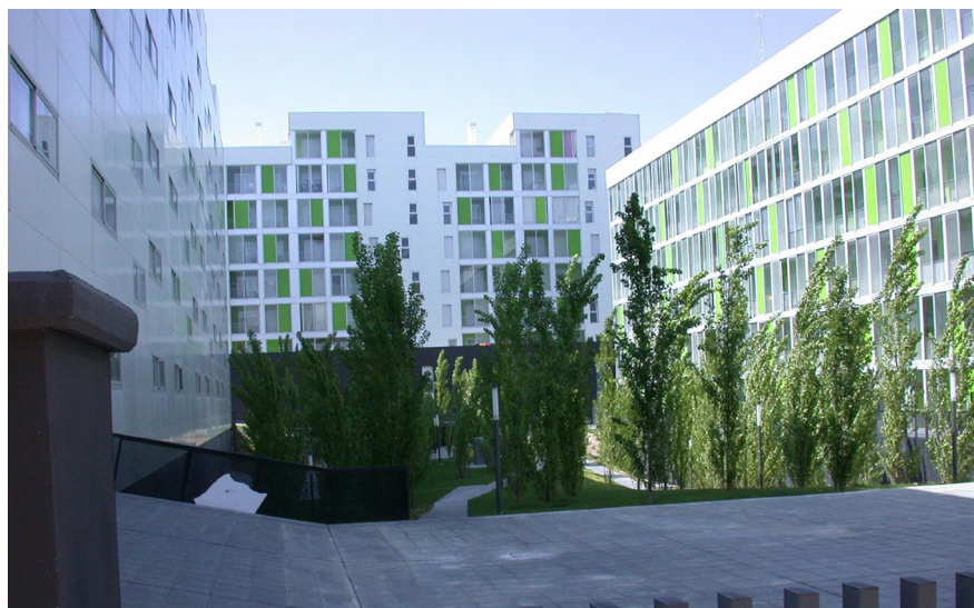
Fig.1: Vista degli edifici, oggetto di retrofitting. Fonte: cittasostenibili.it (2016)
