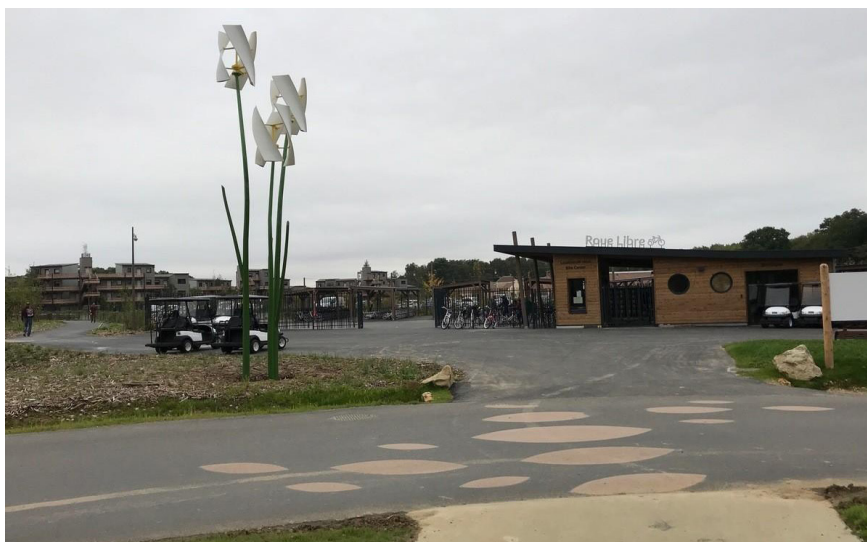
Fig.1: Vista del distretto e del suo sistema viario ciclo-pedonale. Fonte: construction21.org (2018)
