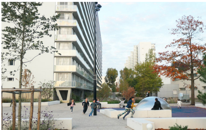
Fig.2: Vista degli edifici residenziali H e I, riqualificati su progetto dello studio Lacaton & Vassal. Fonte: Base Land (2018)
