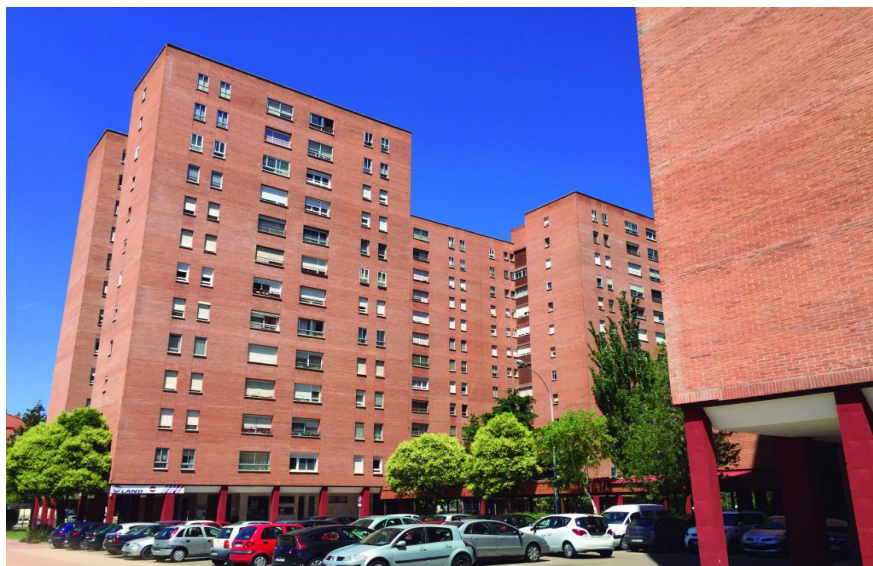
Fig.2: Vista degli edifici del quartiere. Fonte: taghazoutbay.ma (n/d)
