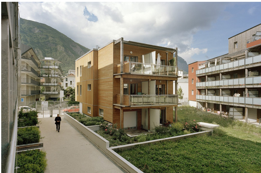
Fig.3: Vista degli edifici, e dell'area verde di quartiere "Ile Verte". Fonte: construction21.fr (2016)
