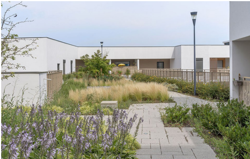
Fig.3: Vista di alcune unità abitative collettive in affitto sociale e di un'area commerciale. Dettaglio del green roof . Fonte: Atelier Thierry Roche (2015)
