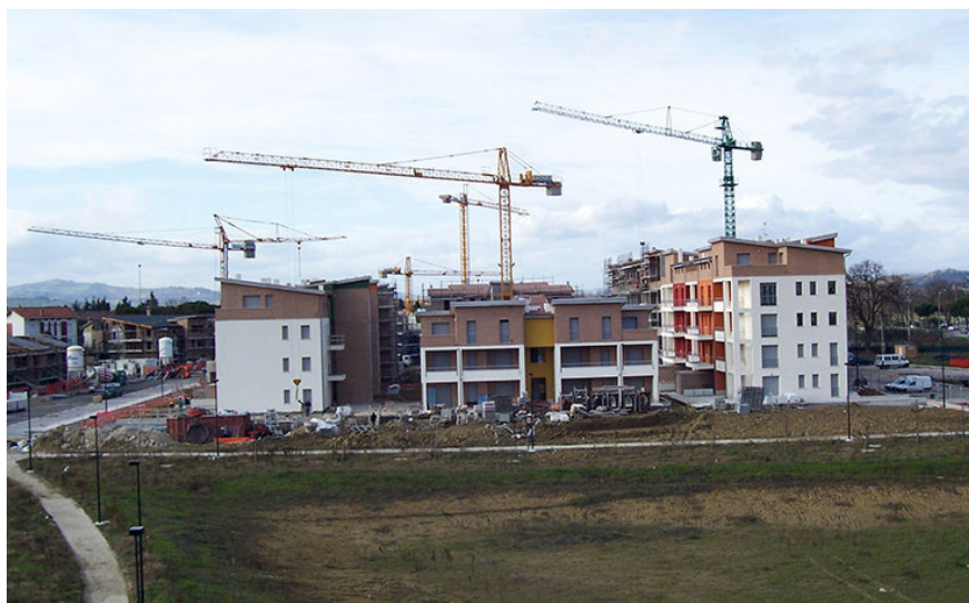
Fig. 1: Vista degli edifici del quartiere durante la fase di costruzione. Fonte: camangiassociati.it (2015)
