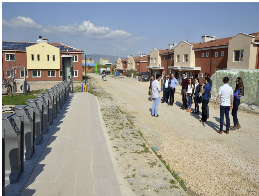
Fig.3: Vista degli edifici del quartiere con le stazioni di ricarica per e-bike in primo piano. Fonte: tepebasi.bel.tr (n/d)
