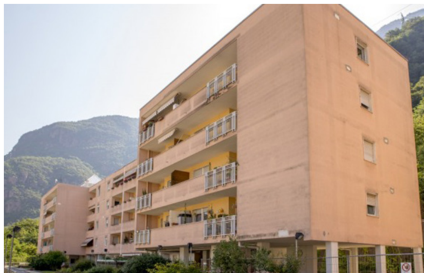
Fig.2: Vista degli edifici del quartiere. Fonte: sinfonia-smartcities.eu (n/d)
