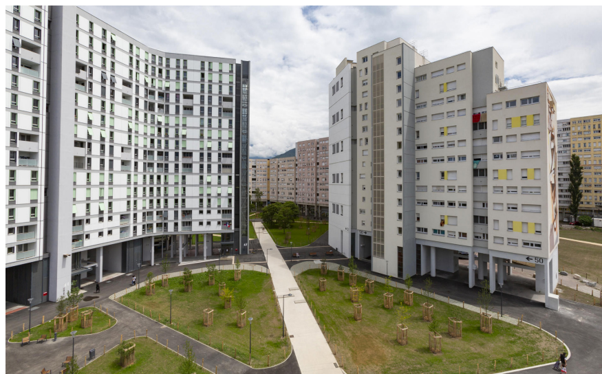
Fig.2: Vista degli edifici, i cui involucri sono ripensati, con particolare attenzione ai dispositivi tecnologici passivi e al miglioramento dell'accessibilità. Fonte: lesvilleneuve.fr (2018)
