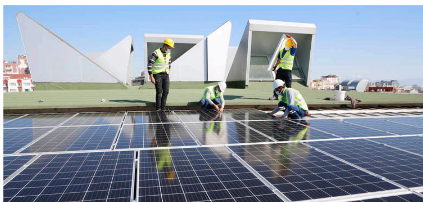
Fig.3: Vista della fase di installazione dell'impianto solare fotovoltaico sulla copertura del centro comunitario. Fonte: matchup-project.eu (2022)
