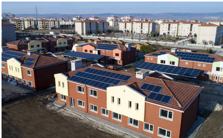
Fig. 1: Vista degli edifici del distretto e dell'integrazione del sistema solare fotovoltaico in copertura. Fonte: tepebasi.bel.tr (n/d)
