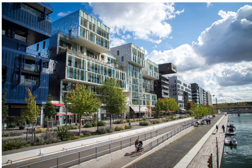
Fig.2: Rapporto tra gli edifici, i percorsi ciclo-pedonali e il waterfront . Fonte: Lyon-Confluence (2015)
