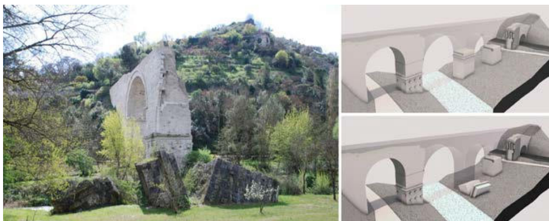
Fig. 2. A sinistra: vista dei resti del ponte e, a destra, schematizzazione della configurazione del ponte pre e post crollo del secondo pilone (modellazione di Wissam Wababeh).
