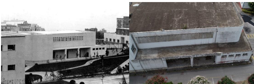
Fig. 13 - Le trasformazioni delle logge, tra tamponamenti e rifacimenti delle strutture
