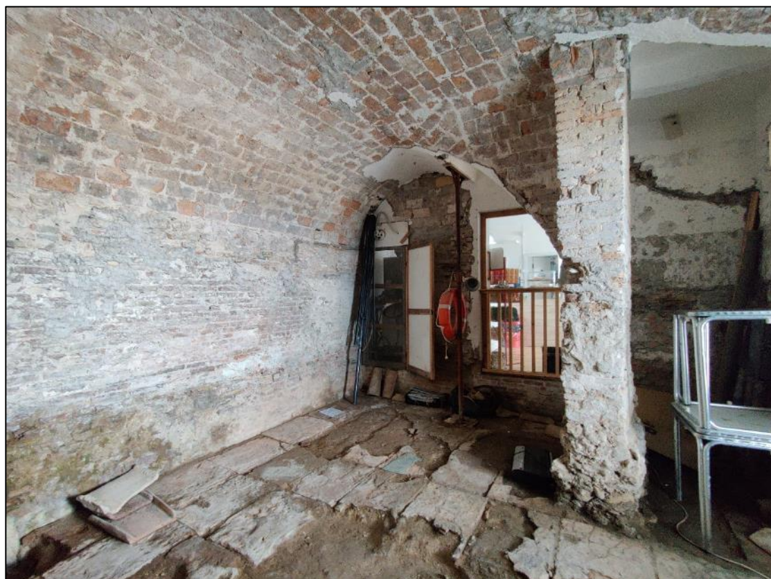
38 - Resti di un edificio termale di età romana presso Casette Santini di Casalbordino (oggi nei sotterranei del bar Finis Terrae), B .
