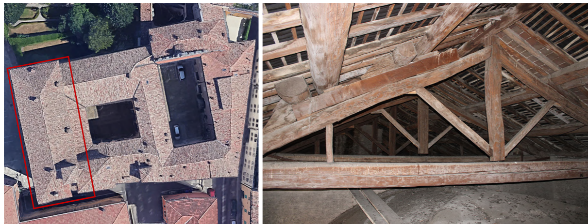
Fig. 1 - A sinistra, vista aerea dell'edificio con individuazione della porzione per la quale è stato sviluppato il modello H-BIM; a destra, foto delle capriate.
