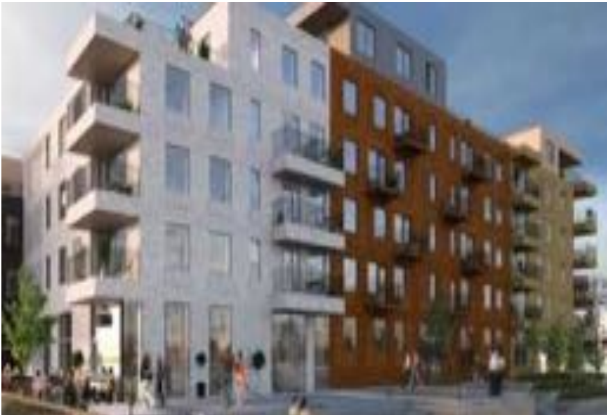
Fig.1: Gli involucri degli edifici presentano soluzioni ibiclimatiche passive quali serre e atri solari a sud e buffer spaces a nord. Fonte: H22.se
