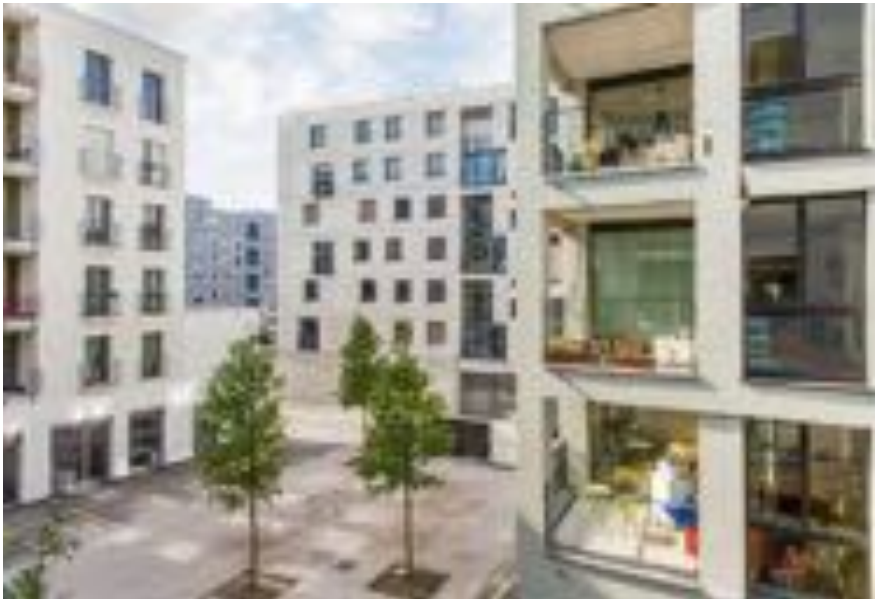
Fig.1: Gli alloggi sono costituiti da soluzioni bioclimatiche passive quali serre e atri solari a sud e buffspaces a nord al fine di massimizzare i carichi energetici. Fonte: Bwo.ch
