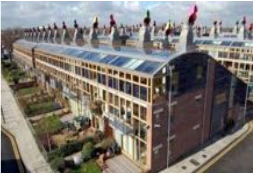
Fig.1: Le coperture degli edifici residenziali che costituiscono il quartiere sono composta da un mix di impianti solari e fotovoltaici ad alte performance di rendimento. Fonte: Zedfactory.com.
