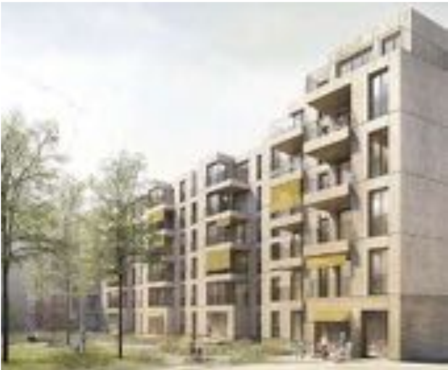
Fig.1: Gli alloggi presentano sistemi di schermatura passiva quali tende e brissoleil in grado di ridurre il carico termico estivo incidente le facciate a sud. Fonte: Induni.ch
