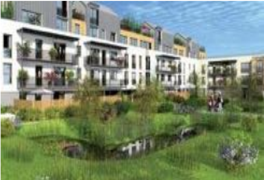
Fig.1: Gli spazi aperti che costituiscono le corti degli edifici sono dotate di sistemi tecnologici ambientali quali impianti di fitodepurazione e laghi biotipi. Fonte: Construction21.
