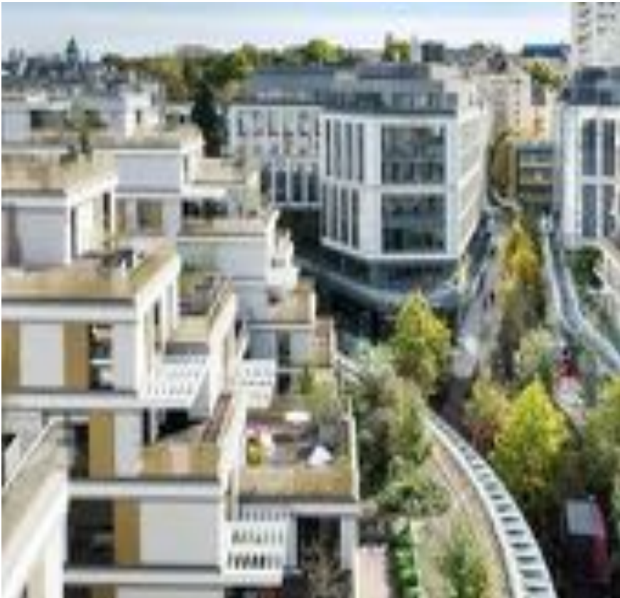
Fig.2: Gli spazi esterni sono caratterizzati da ampie superfici permeabili ove sono stati integrati sistemi tecnologici ambientali quali bioswales e raingarden. Fonte: Construction21.
