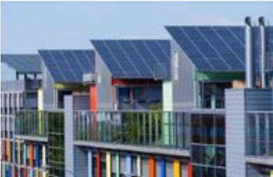
Fig.1: L'elevato mix energetico, esclusivamente da fonti rinnovabili, presente all'interno dell'eco quartiere, permette la neutralità carbonica e climatica dello stesso. Fonte: Construction21.
