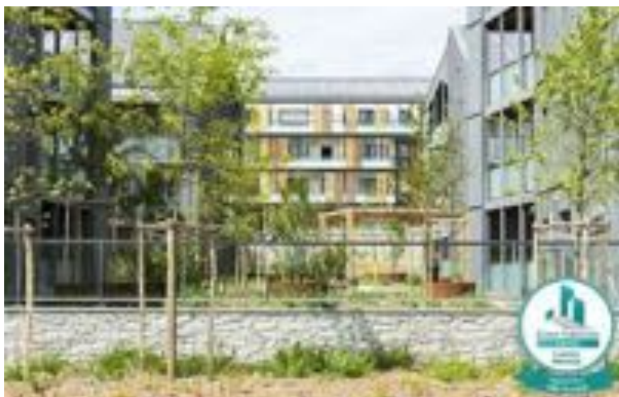
Fig.1: Vista degli edifici i cui involucri sono studiati per massimizzare il comportamento bioclimatico passivo. Fonte: Loire-Atlantique Développement (2022)
