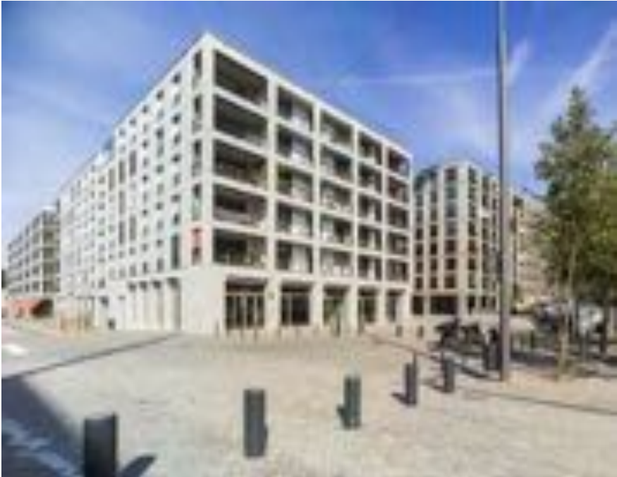
Fig.1: Gli alloggi che costituiscono gli edifici residenziali presentano atri e serre solari a sud al fine di massimizzare i carichi energetici estivi. Fonte: Construction21.
