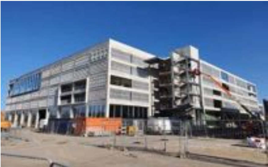
Fig.1: Gli edifici presentano soluzioni bioclimatiche passive quali ampie schermature solari, le quali definiscono il landmark dei prospetti. Fonte: Constrction21.
