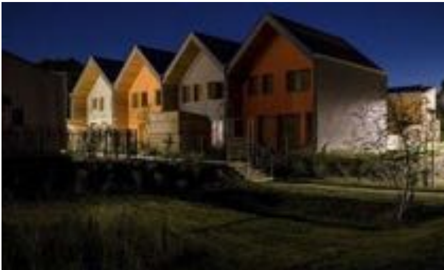
Fig.1: Vista degli edifici, i cui involucri sono progettati con particolare attenzione rivolta ai dispositivi bioclimatici passivi. Fonte: construction21.org (2017)
