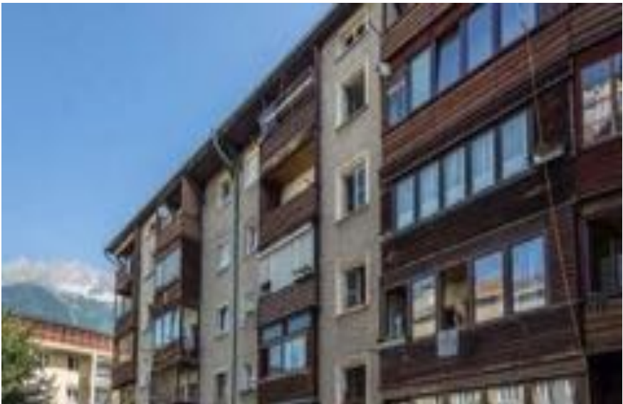
Fig.3: Nei fronti a Nord degli edifici sono stati adottati sistemi bioclimatici passivi quasi i buffer spaces. Fonte: Synphonia Smart Cities.
